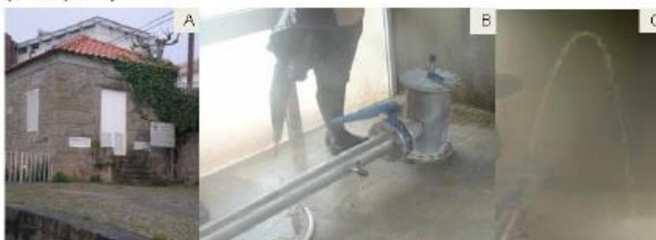
**Figura 2.** A- Caseta da Nascente Tradicional; B – Interior da caseta do Furo AC<sub>1</sub>, com 500 m de comprimento; C – Débito do furo AC<sub>1</sub>, por artesianismo repuxante.
