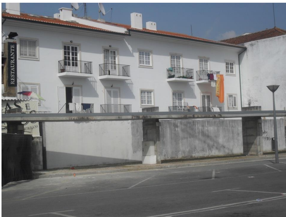
Fot. 6 – Vista do muro construída como medida de proteção contra inundações na baixa de Águeda.
