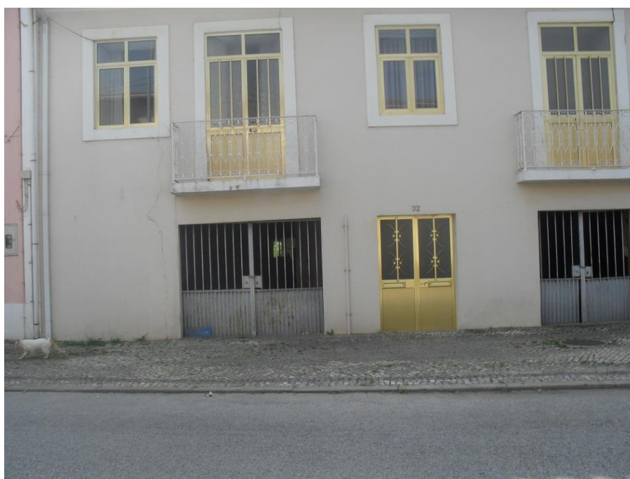
Fot. 5 – Um exemplo de wet flooding .
