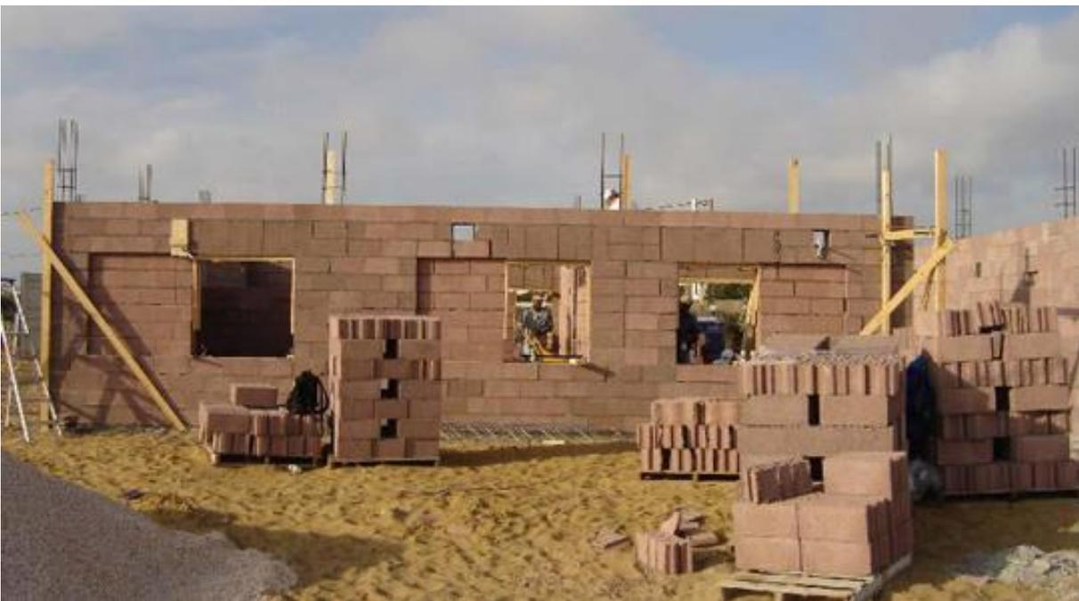
Figura 19 – Construção de um conjunto habitacional usando técnicas da alvenaria estrutural no Algarve
