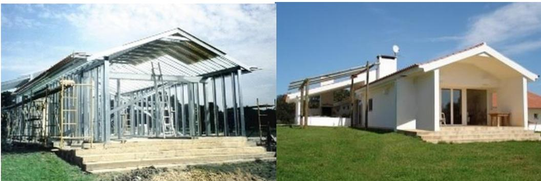
Figura 23 – Estrutura montada e aspecto final da obra – Sistema Light Gauge Steel Framing
