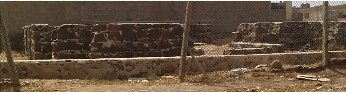
Figura 8 – Pedra Basáltica na construção de uma habitação em Cabo Verde, Ilha do Sal
