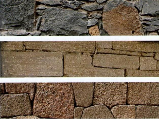
Figura 7 – Pedras existentes em Cabo Verde: Basáltica, Pozolana, Calcária
