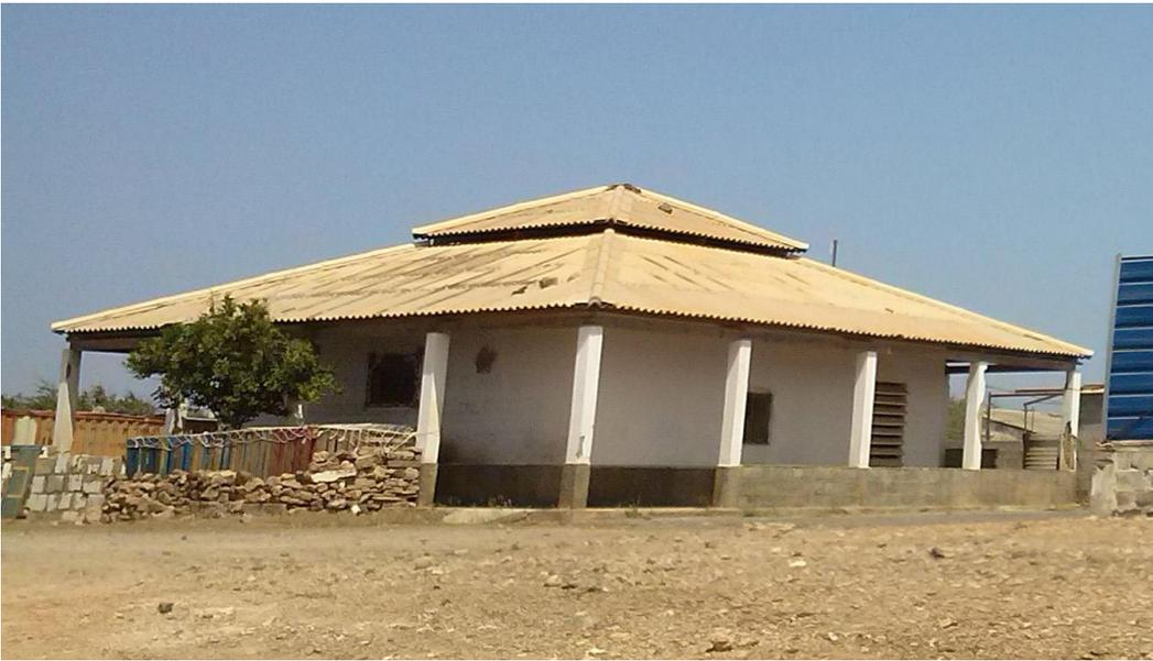
Figura 27 – Projeção do telhado para sombreamento da envolvente, ventilação do desvão da cobertura pela cumeeira, na Ilha do Sal
