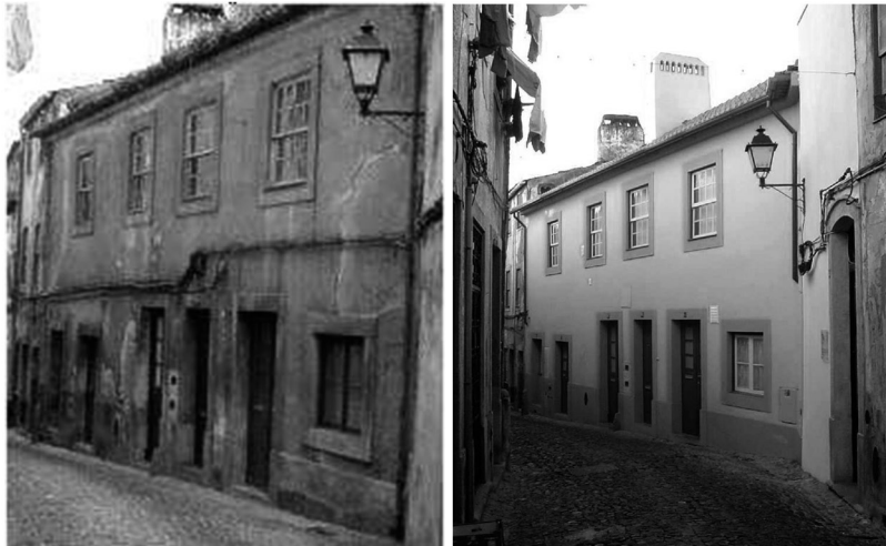
30. Área de intervenção programa PRAUD 31. Edifício reabilitado pelo programa PRAUD
