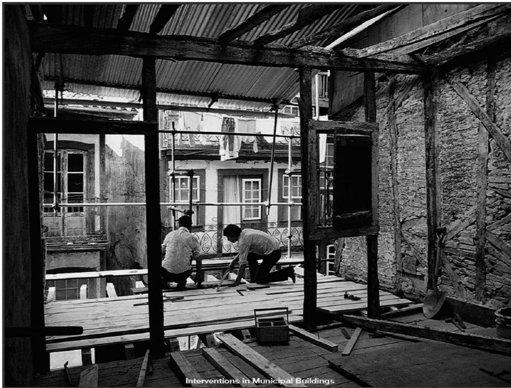
27. Processo de reabilitação da Casa da Rua Nova
