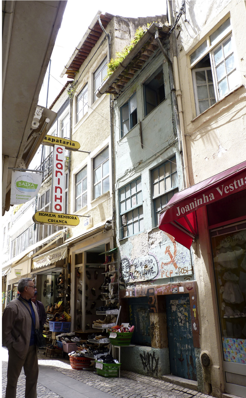
78. Edifício intervençionado na proposta - rua da Louça
