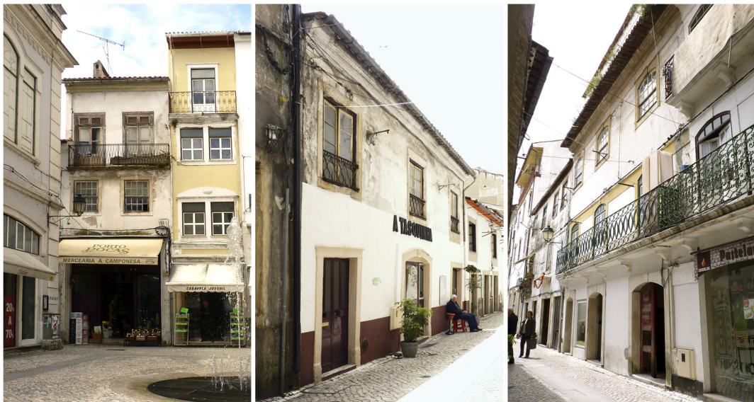
80. Edifícios intervencionados na proposta urbana rua da Louça | rua da Moeda sul | rua da Moeda norte
