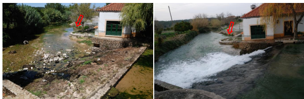
Figura II.1.5 – O contributo da secção menor de vazão para o total de caudal nos Olhos d'Água do Anços e a sua relação com a altura de água no descarregador – durante a estiagem (foto lado esquerdo) e no Inverno (foto lado direito)
