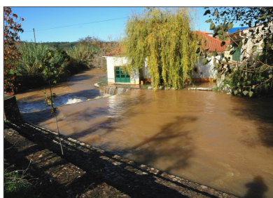
Figura II.IV.IV.2 – Sedimentos em suspensão indicando a existência de circulação hipogea em regime turbulento (em condutas), no seguimento de recarga abundante e concentrada (111 mm de precipitação nos dois dias anteriores). Dia 17/11/2009, 12h; caudal instantâneo: 4,56 m 3 /s
