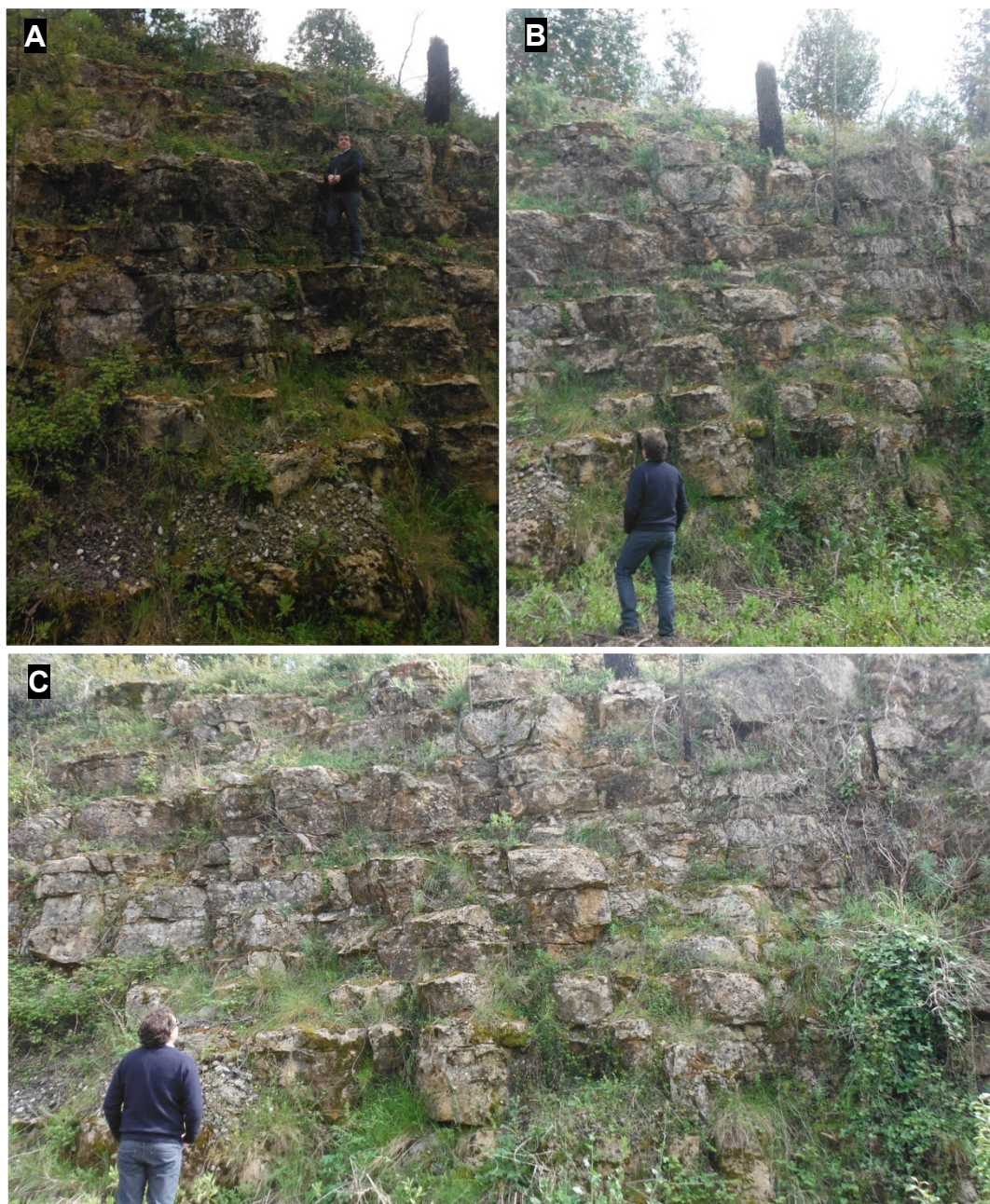
Fig. 60 – Aspetos de campo do perfil de Vale Faval (n.º 155): (A), (B) e (C) – Vista geral e atual (ano 2014) do afloramento calco-dolomítico; os estratos mais espessos de dolomitos (da ordem dos 60 cm até 1 m) patenteiam uma textura oolítica e/ou bioclástica, interstratificando com camadas mais finas e regulares de dolomitos margosos essencialmente micríticos. Para a posição estratigráfica dos corpos líticos referidos ver a coluna estratigráfica patente na Figura 61 .
