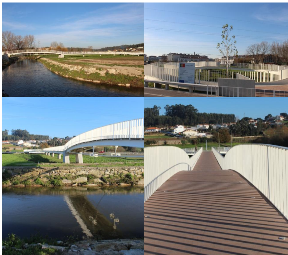
Figuras 97 a 100. Ponte Pedonal/Ciclável do Parque Municipal do Antuã
