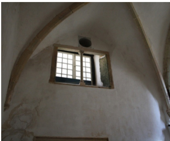
F.464 Janela aberta na parede.
