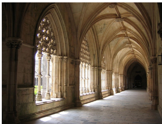
F. 452 Claustro Real, Mosteiro da Batalha.
