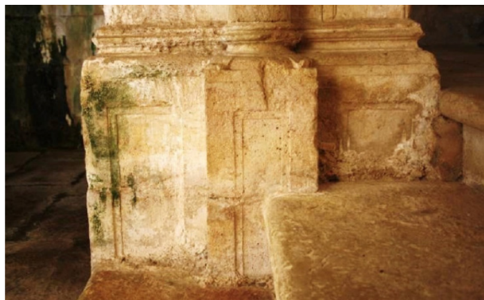
Fig. 372 Encaixe de degraus no pórtico pré existentes e pertencente ao primeiro Claustro Principal de Diogo de Castilho
