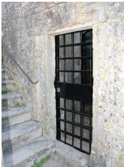
Fig. 23 Vista geral da porta de acesso à ante câmara.
