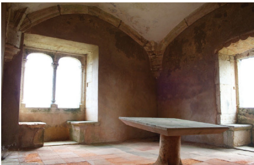
Fig. 67 Câmara do 1º piso da torre de D. Catarina com abóbada em substituição do tecto em madeira.
