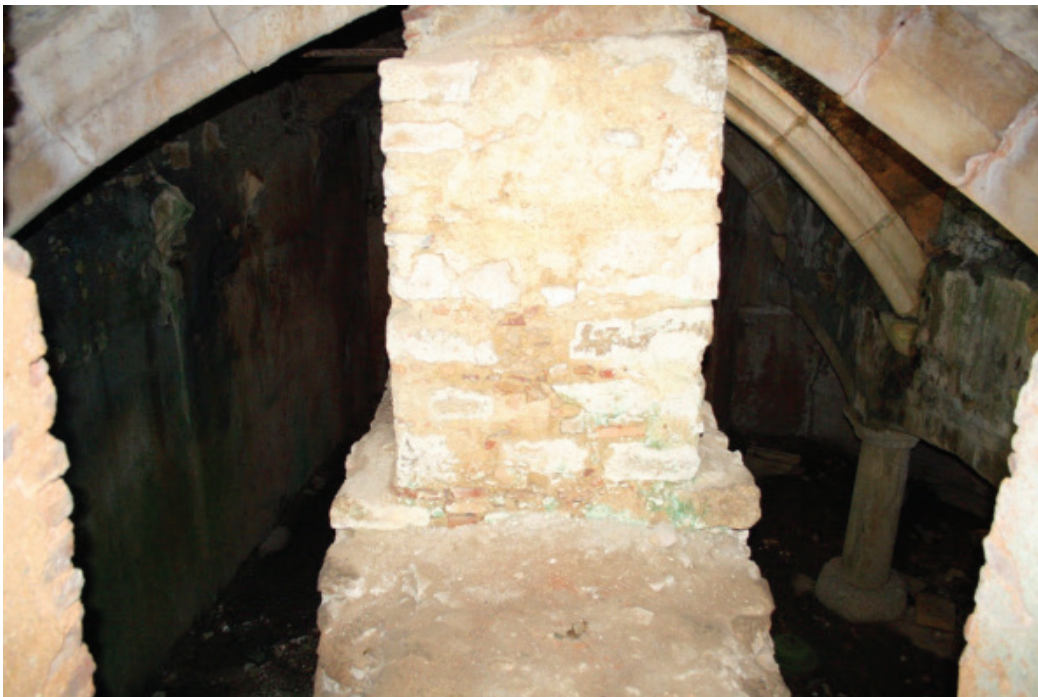
Fig. 76 Vista da cota da tribuna sobre a sala de audiências (perspectiva truncada pela parede construída no centro da sala).
