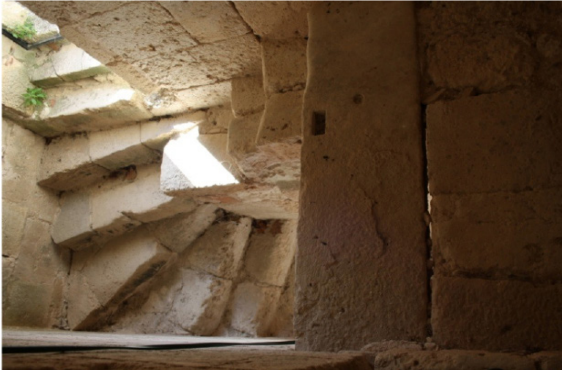
Fig. 94 Escadaria militar, acesso à nave manuelina e ao piso superior da Charola.
