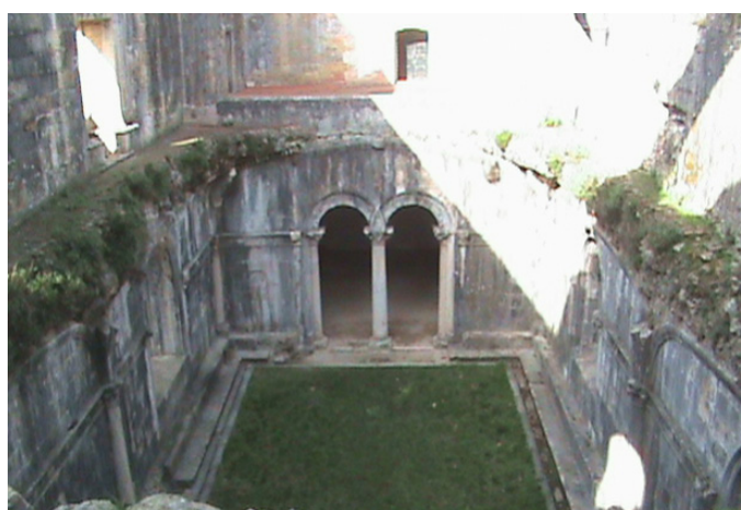
F.430 Dupla arcaria de acesso ao vestíbulo do capítulo dos clérigos.
