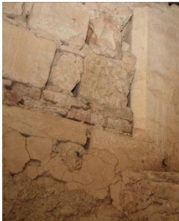
F.489 Vão de comunicação entre dependências do 1º piso.
