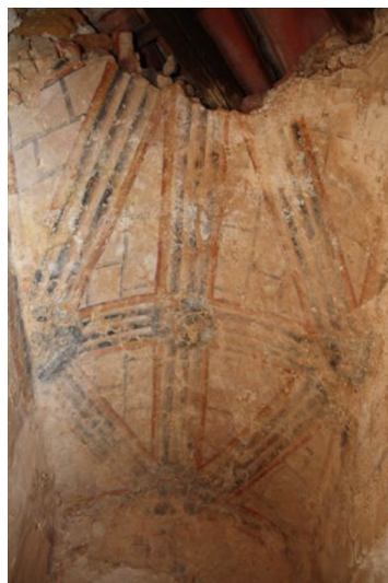
Fig. 21 Pormenor da pintura da abóbada do corredor de entrada no Cartório da Ordem, localizado piso superior da Charola.
