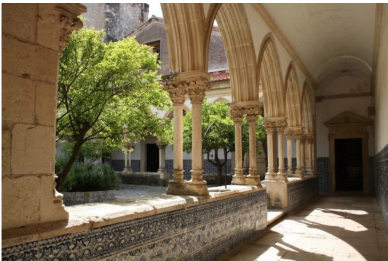
F. 457 Revestimento azulejar nos claustros do Cemitério.
