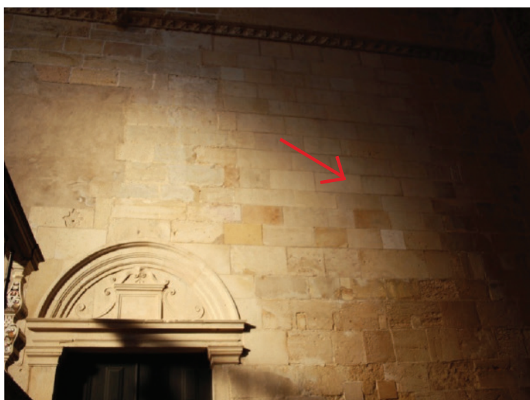
F. 353 Vestígios pertencentes à estrutura do antigo órgão de tubos.
