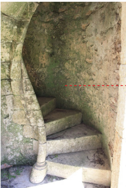
F.531 Escada de acesso.
