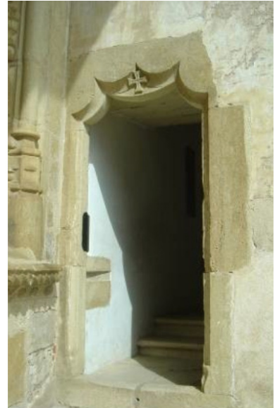
F.479 Vão de acesso.
