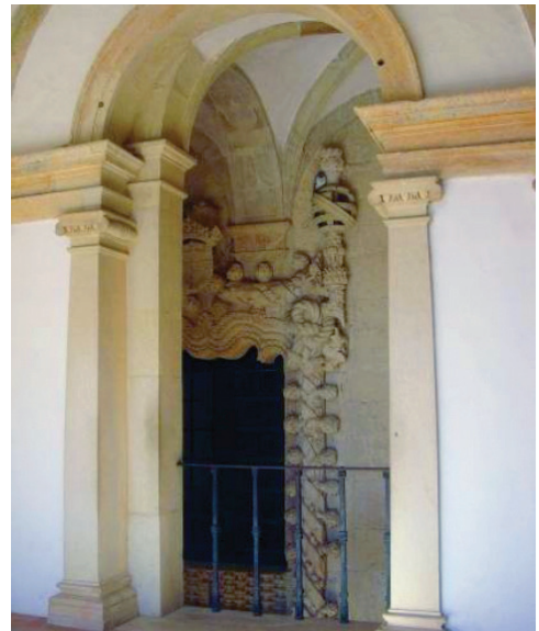
F. 386 Janela da sacristia enclausurada pelo claustro Principal.
