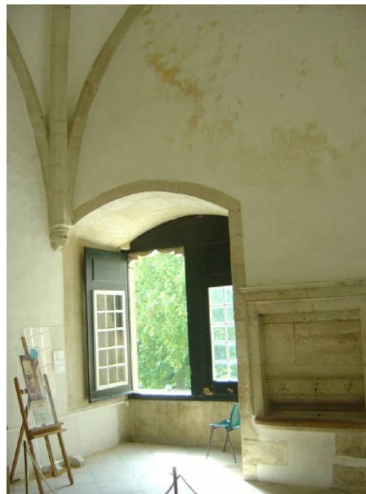
F.481 Lavatório e janela da parede Sul.
