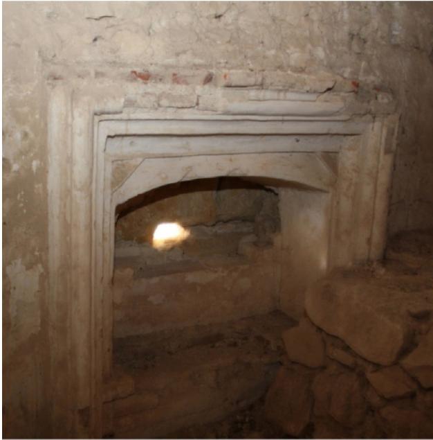
F.473 Vão entaipado de ligação do claustro à igreja.
