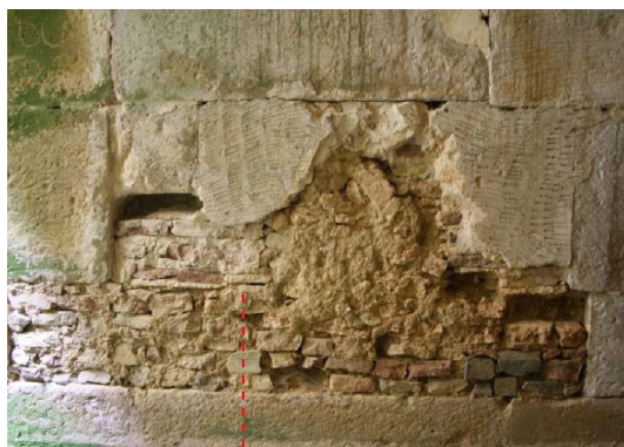
Fig. 378 Vão entaipado com acabamento de capeamento de alvenaria de pedra, que fazia a ligação entre o Convento e o arrabalde de São Martinho.
