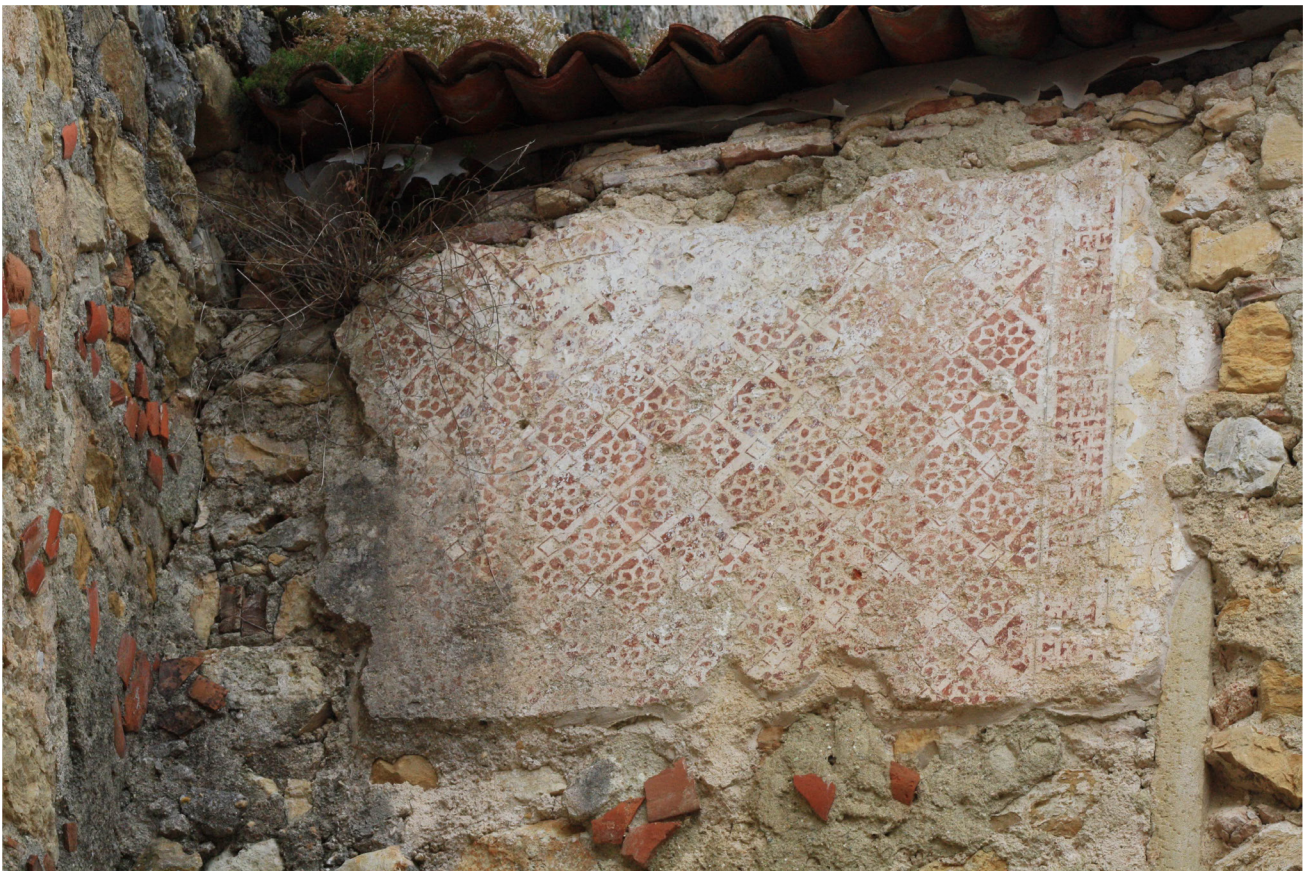
F. 528 Vestígios de pintura parietal da sala do paço, com motivos geométricos.
