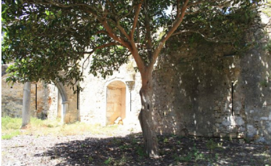
F.530 Misulas de arranque da abóbada.
