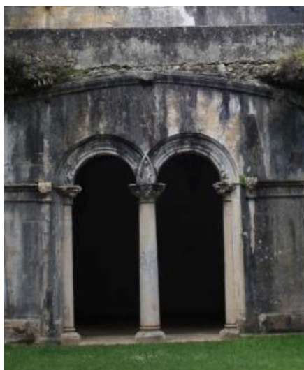
F.445 Sala do capítulo clerezia, entrada no vestíbulo.
