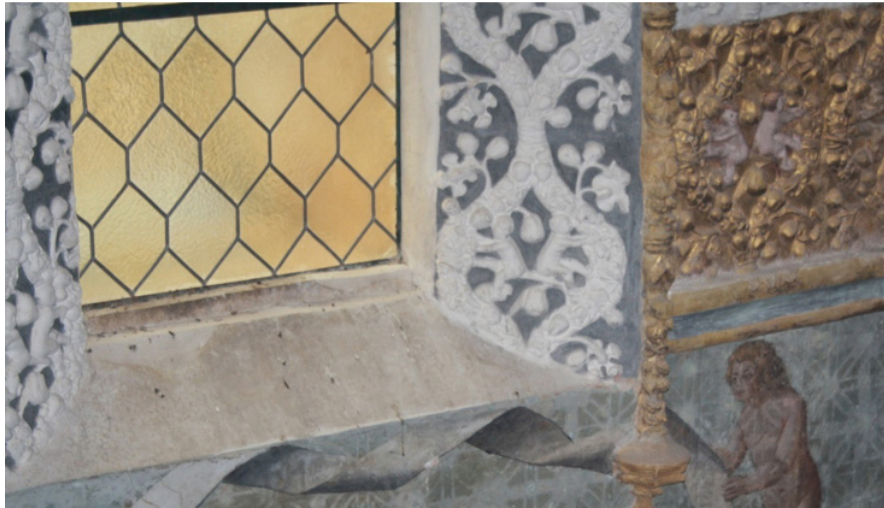
Fig. 351 Remate superior dos tramos do deambulatório.
