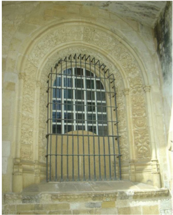
Fig. 33 Transformação da antiga porta dos leigos da Charola, em janela.
