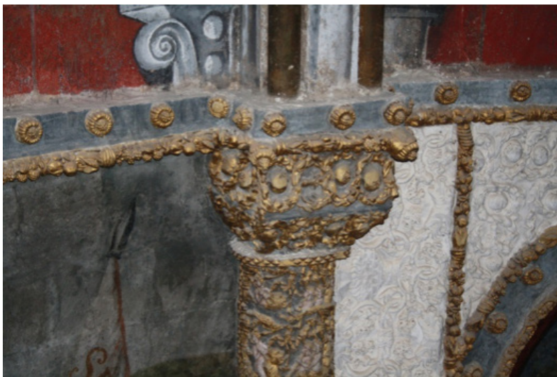
Fig. 34: Remate superior dos tramos do deambulatório.
