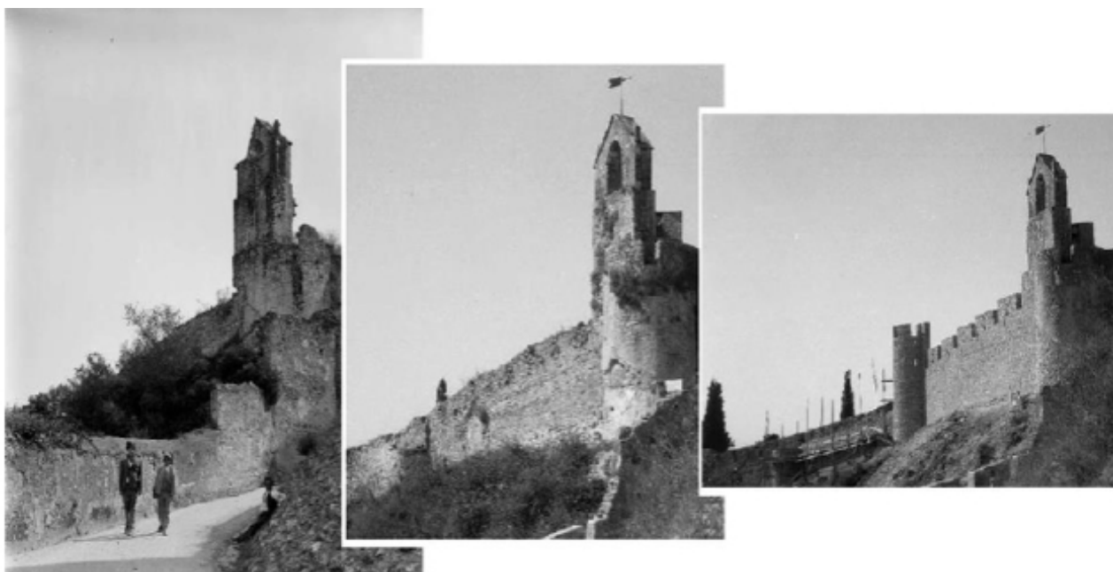
Fig. 46 Torre sineira de Santa Maria do Castelo (três fases distintas dos trabalhos de recuperação do início do século XX). Postais antigos do arquivo do Turismo de Tomar.
