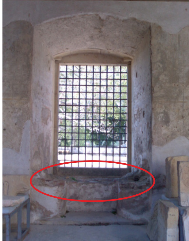
F.500 Área ocupada pela estrutura cerâmica acoplada à janela.
