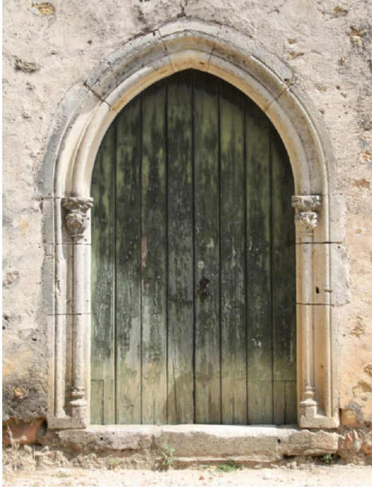
F.513 Porta exterior no piso térreo do claustro da Lavagem.
