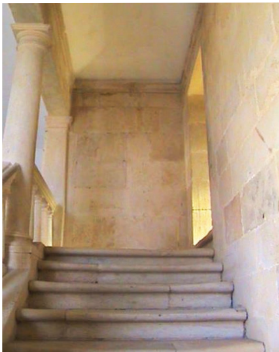
F. 351 Escada actual de acesso ao coro alto (lado norte).
