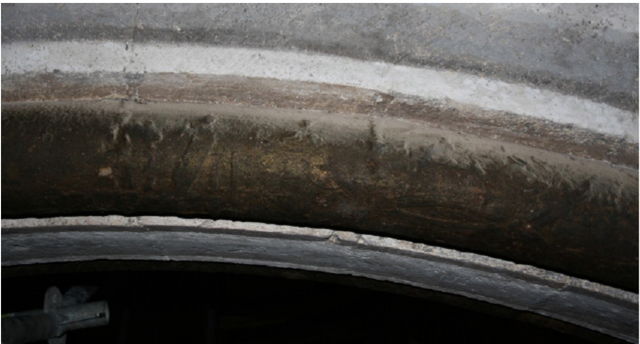
Fig. 342 Abóbada de canhão do deambulatório – nervuras cobertas com guadamecil.
