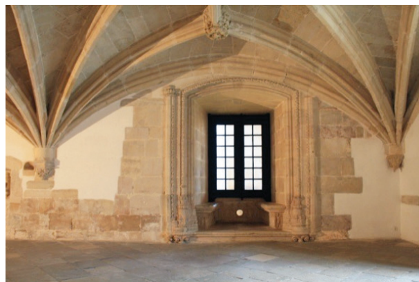
F. 344 Tramo poente da abóbada da sacristia.
