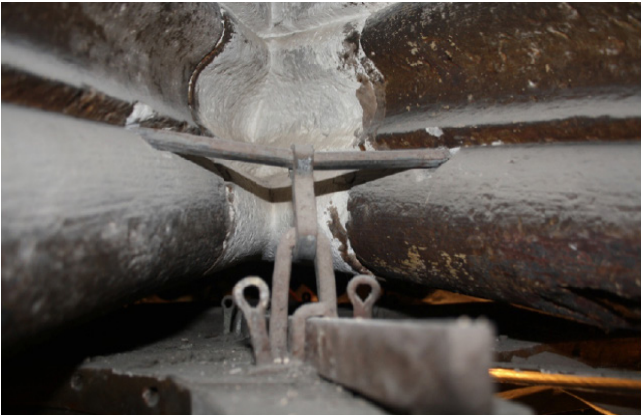
Fig. 37 Aplicação de guadamecil até quase ao limite do fecho da abóbada e mecanismo de suspensão do actual elemento em talha.
