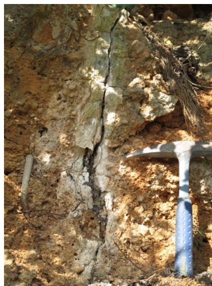
Fotografia 6.27 – Pormenor de impregnação carbonatada fissural (Goncinha)
