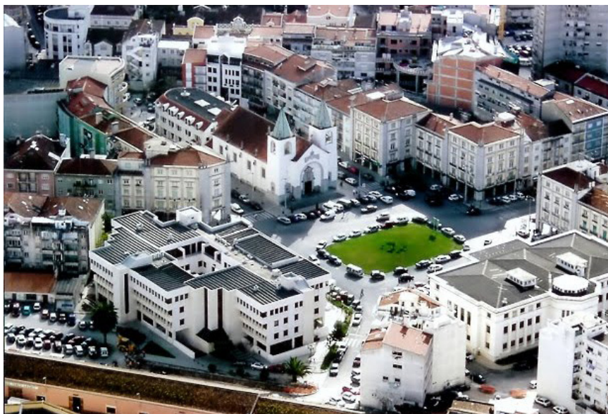
Fig. 37 - Vista aérea da Câmara Municipal de Caldas da Rainha
