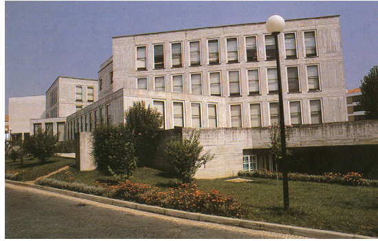
Fig. 94 - Vista da entrada do estacionamento
