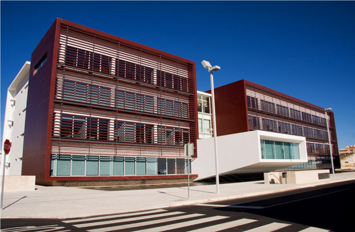
Fig. 179 - Câmara Municipal de Lagos
