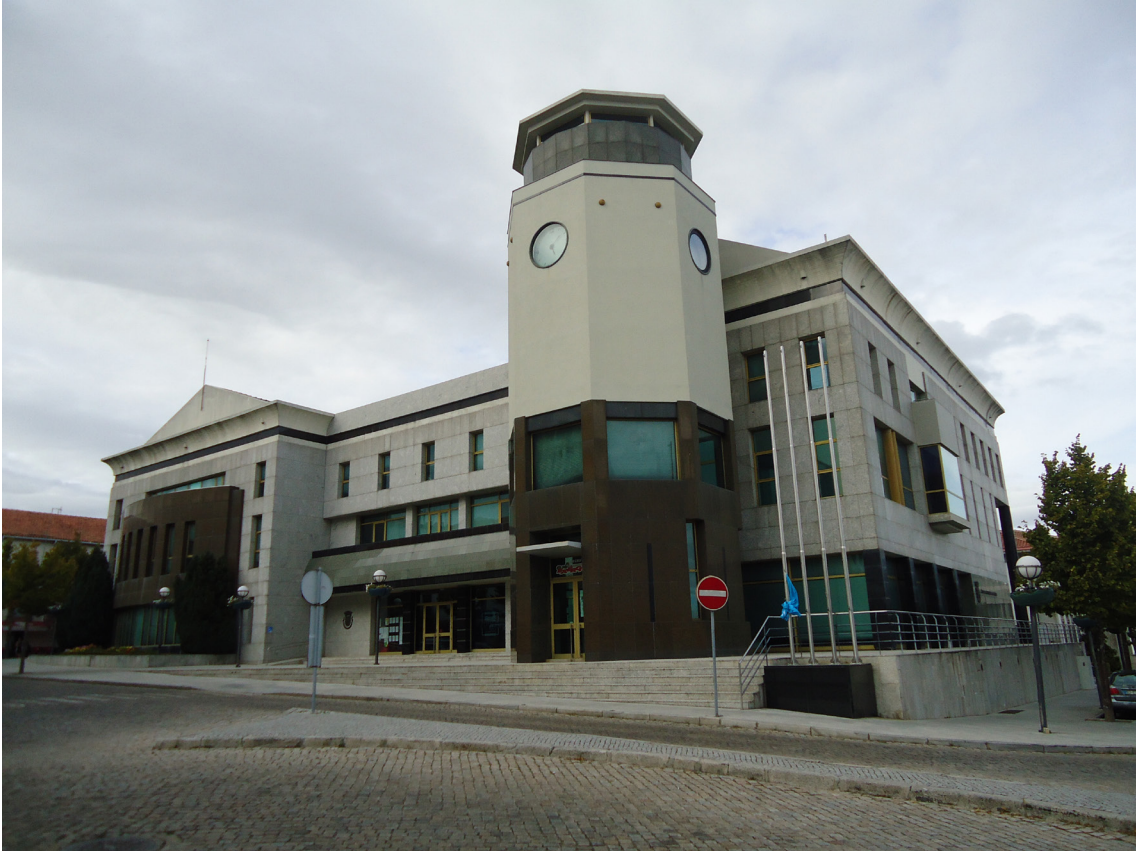
Fig.159 - Câmara Municipal da Guarda
