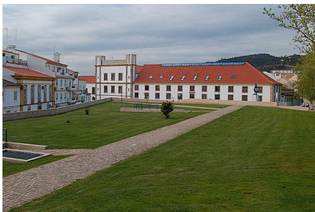
Fig. 30 - Vista da parte superior do parque de estacionamento para Câmara Municipal de Portalegre, 2005
