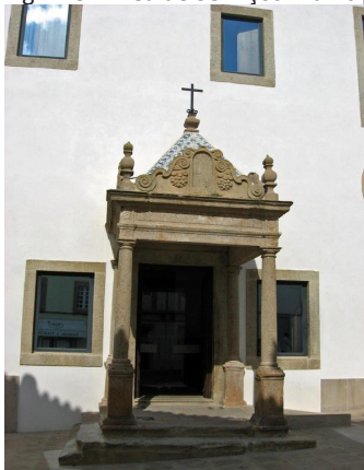
Fig. 245 - Pórtico de entrada
