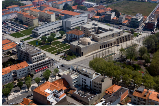
Fig. 116 - Vista aérea do conjunto
