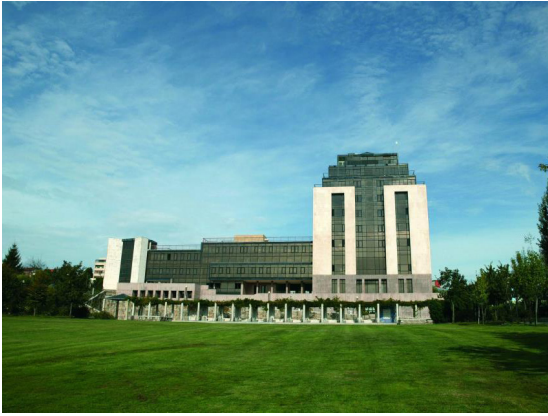
Fig. 139 - Vista do jardim para a Câmara Municipal
