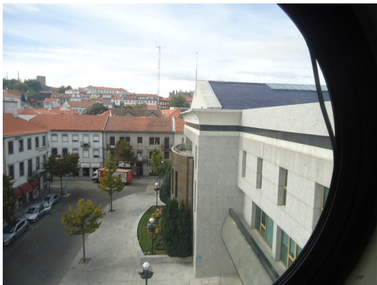
Fig. 165 - Vista da torre do relógio
