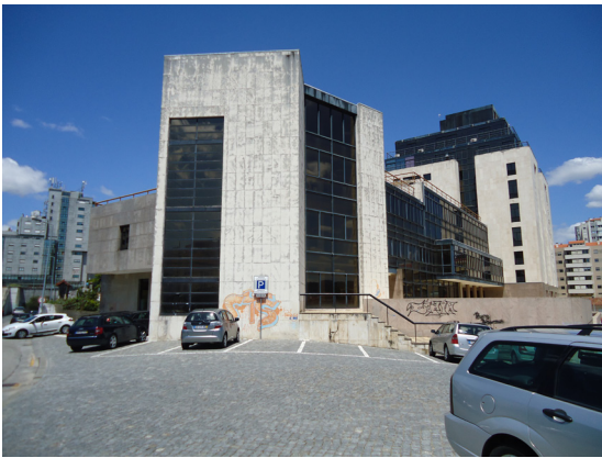
Fig. 141 - Caixa de escadas exterior
