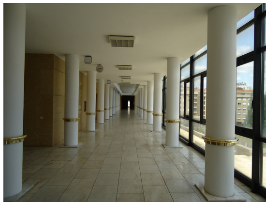
Fig. 144 - Galeria no piso 1
