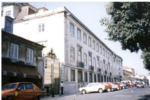
Fig. 2 -Fachada Principal do Convento de Jesus de Lisboa
