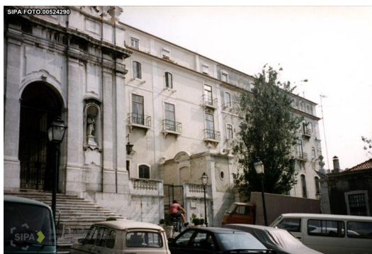
Fig. 3 - Fachada lateral do Convento de Jesus de Lisboa
