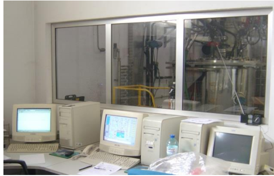
Figura 1.17: Sala de controlo da linha A de Polimerização.
