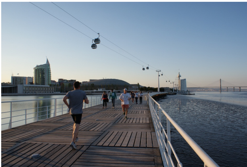
Fig. 78 - Passadiço pedonal junto à Doca dos Olivais.
