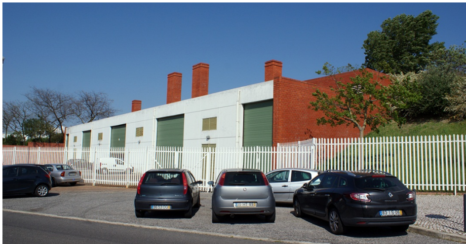
Fig. 124 - Central Sul, vista exterior.
