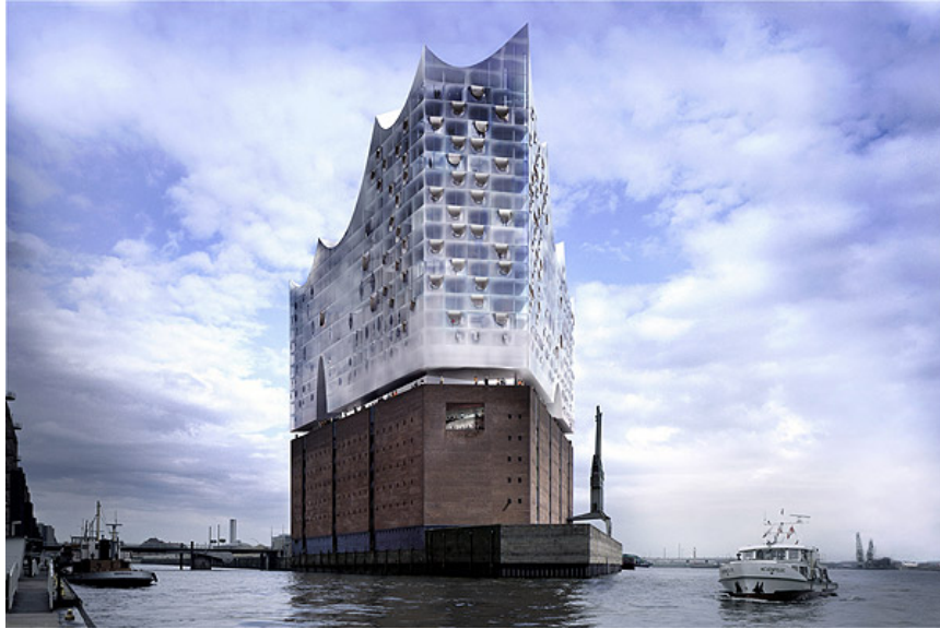
Fig. 169 - Elbphilharmonie, Herzog & de Meuron.
