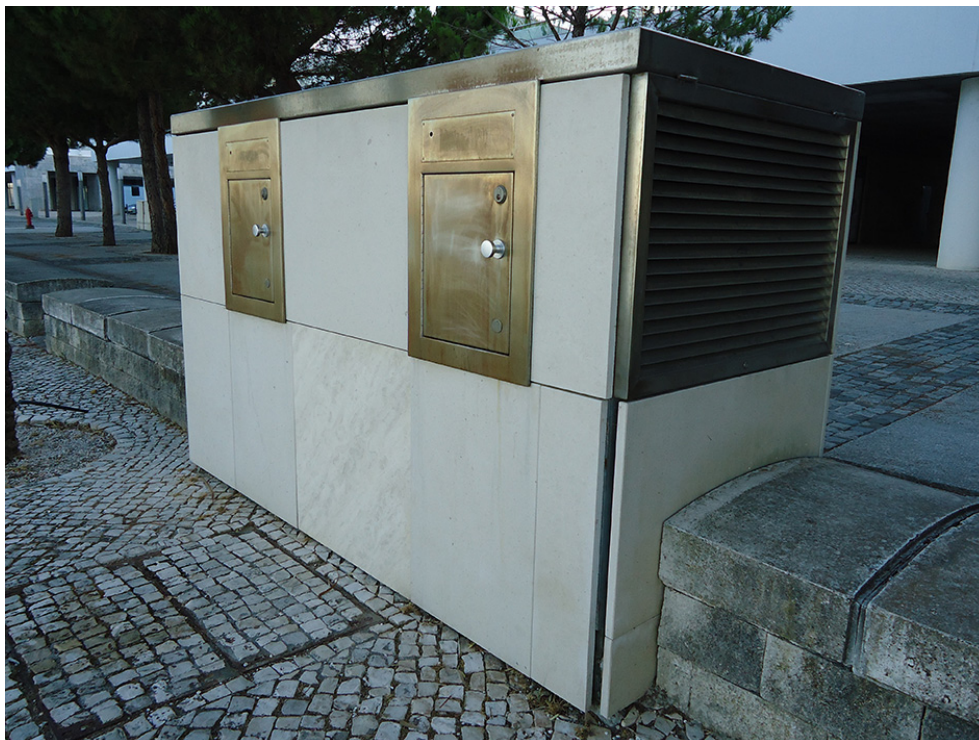
Fig. 110 - Bocas de recolha pública integradas no desenho dos muros de suporte na Zona Sul, vista frontal.
