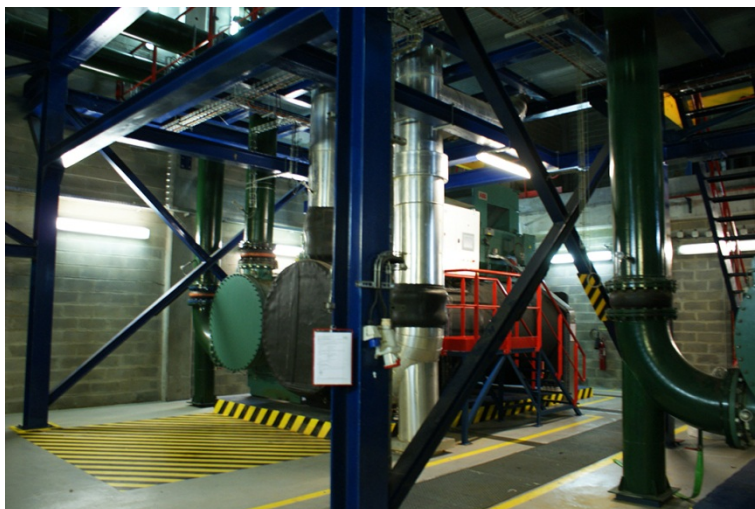
Interior do pavilhão técnico.
