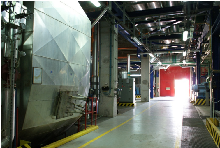
Interior do pavilhão técnico.
