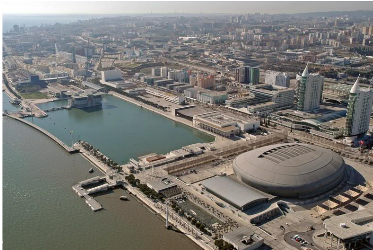
Fig. 68 - Espaço urbano após a abertura como Parque das Nações.
