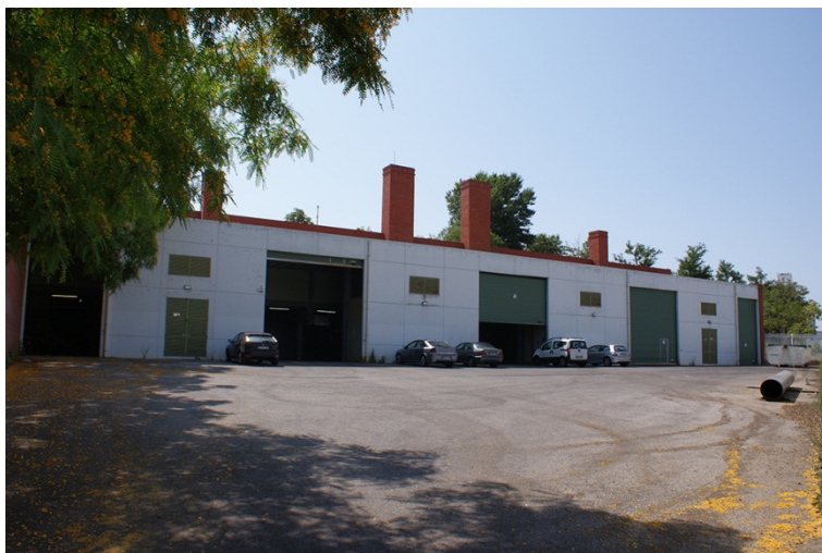
Vista da zona de entrada do edifício.
