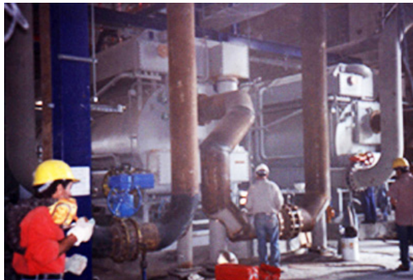
Fig. 131 - Construção da Central de Trigeração.
