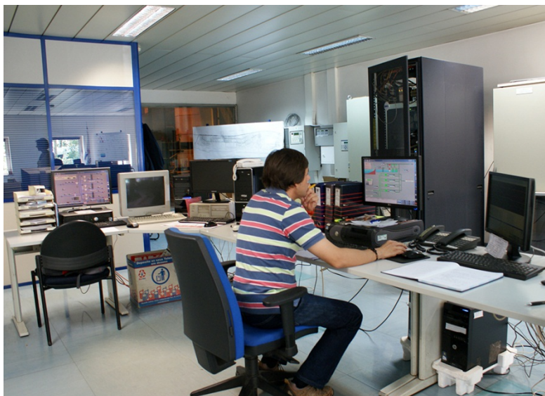
Fig. 138 - Sala de controlo e comando.
