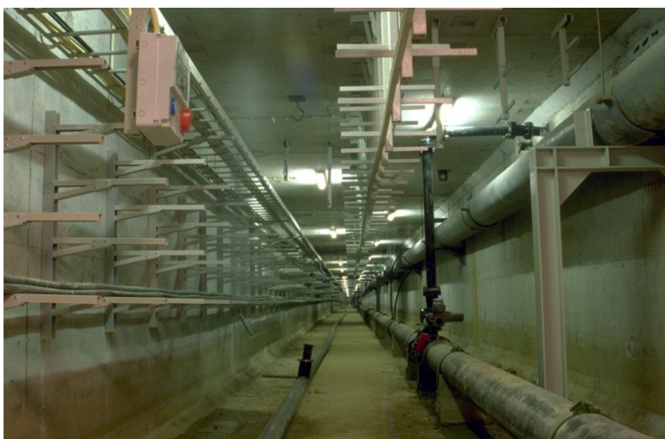
Fig. 97 - Estruturas metálicas de suporte fixadas no interior, ainda no processo de construção.
