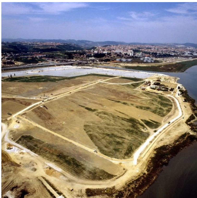
Fig. 53 - Aterro Sanitário de Beirolas após estabilização e selagem.
