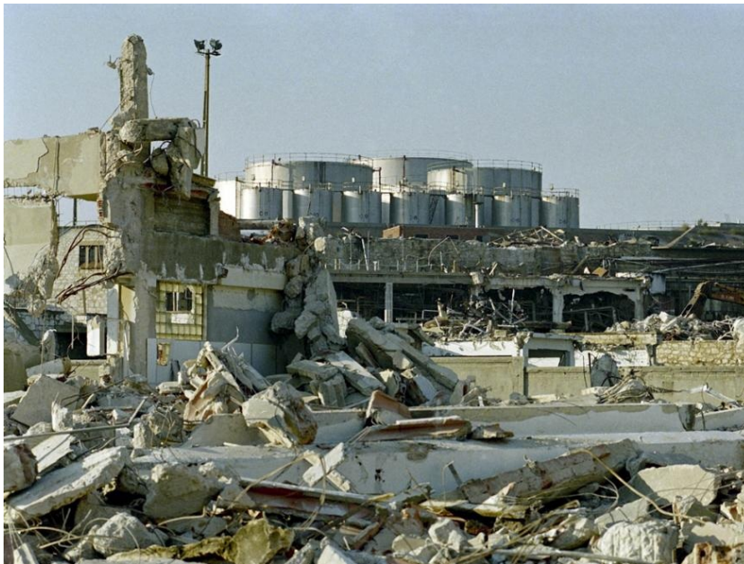
Fig. 49 - Demolição dos edifícios e estruturas existentes.
