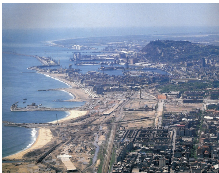
Fig. 38 - As obras na “fachada marítima” da Barcelona olímpica.
