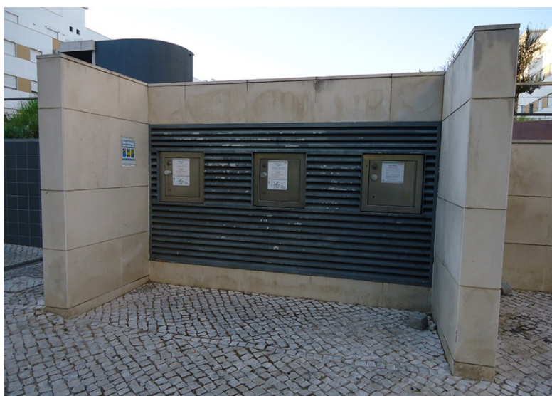
Fig. 119 - Bocas de recolha da fração de recicláveis associadas à comporta de vazamento para resíduos de limpeza do logradouro.
