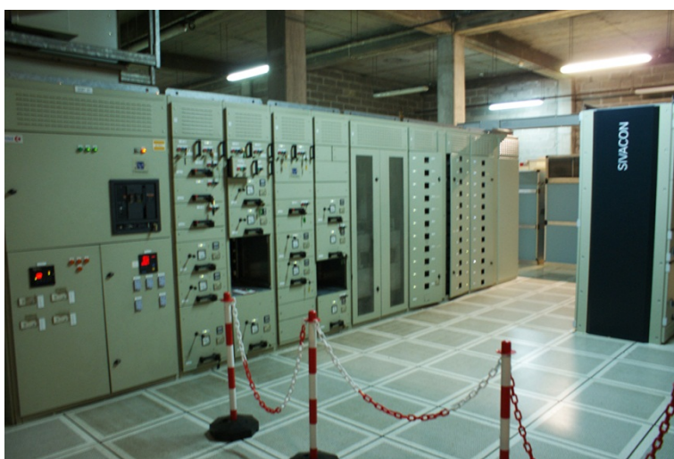
Sistema de gestão técnica centralizada.
