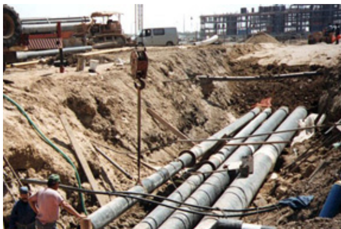
Fig. 143 - Restantes ramais da rede – a quatro tubos, pré-isolados – inseridos em vala.
