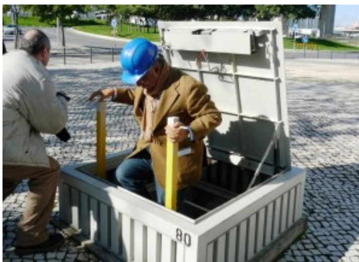
Fig. 99 - Um dos pontos de acesso, aqui aberto, durante uma visita do presidente da CML, António Costa, à galeria, em 2012.
