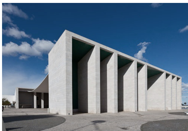
Fig. 72 - Pavilhão de Portugal, Álvaro Siza Vieira.
