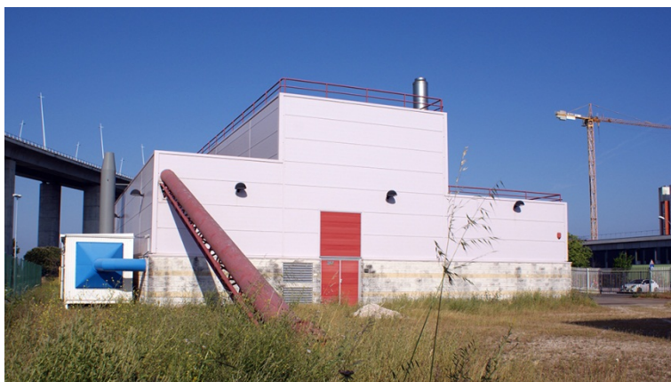
Fachada lateral onde se integra a conduta de chegada dos resíduos.
