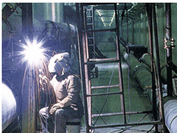
Fig. 133 - Instalação das tubagens na Galeria Técnica.
