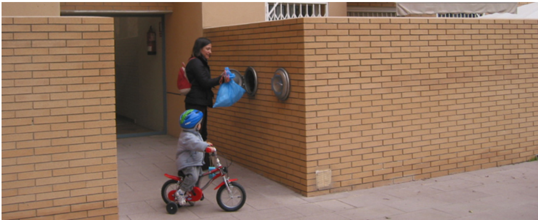
Fig. 106 - O sistema instalado na Vila Olímpica, Barcelona
