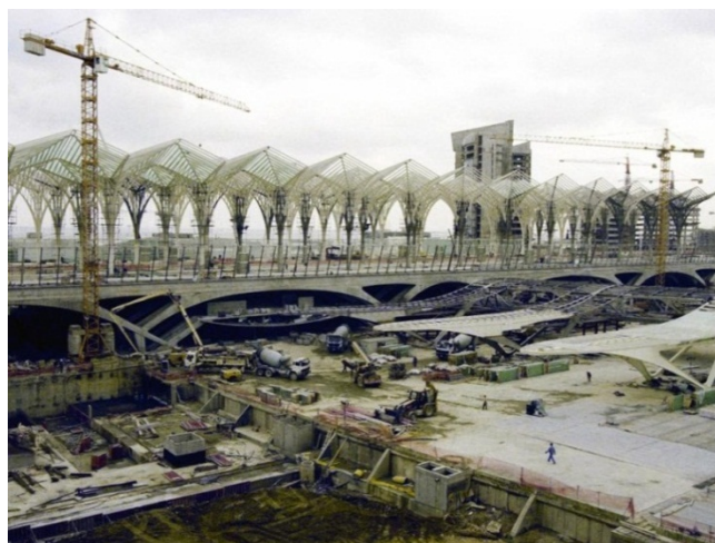
Fig. 65 - Construção da Gare do Oriente.
