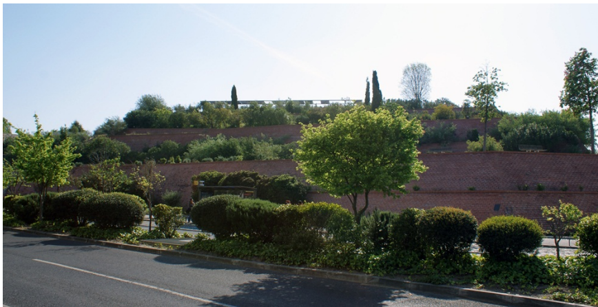
Fig. 89 - Taludes do Jardim do Cabeço das Rolas.
