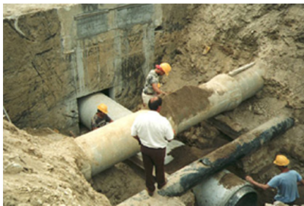
Fig. 132 - Construção da rede de distribuição.
