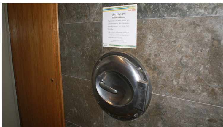
Fig. 116 - Vista aproximada da incorporação da boca de recolha.
