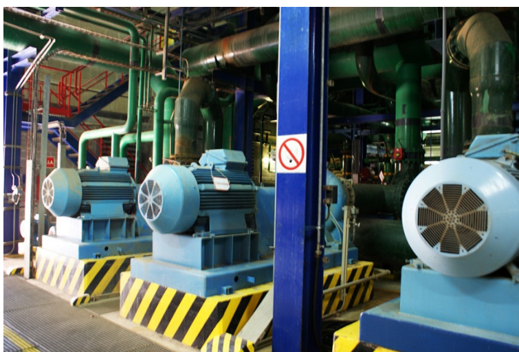
Interior do pavilhão técnico.
