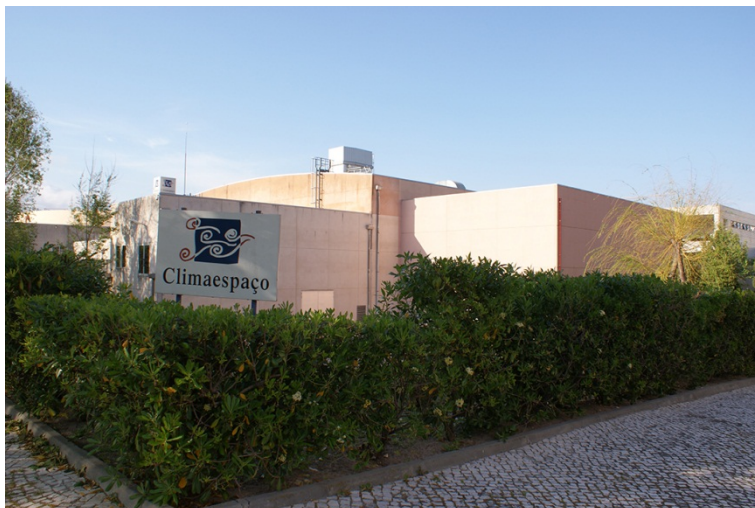
Exterior do edifício.
