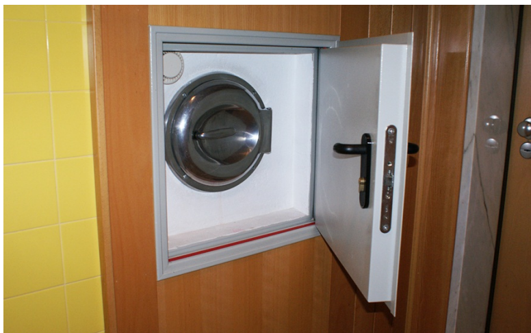
Fig. 117 - Exemplo de boca de recolha interior com porta dupla.
