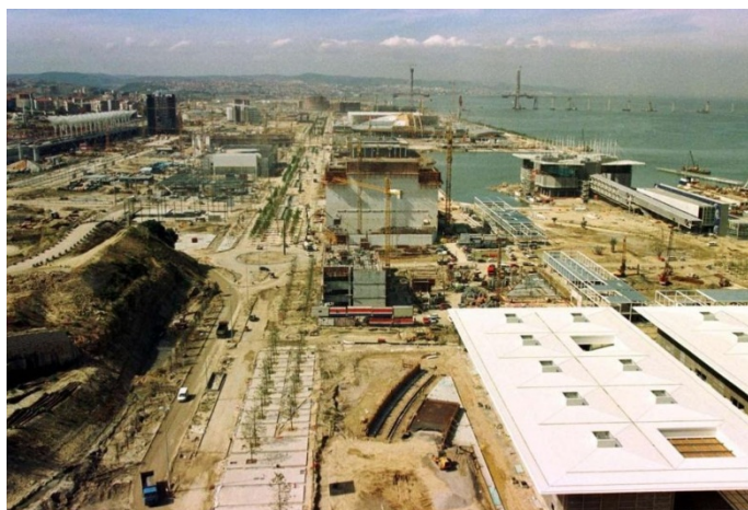
Fig. 66 - Construção do recinto da exposição.
