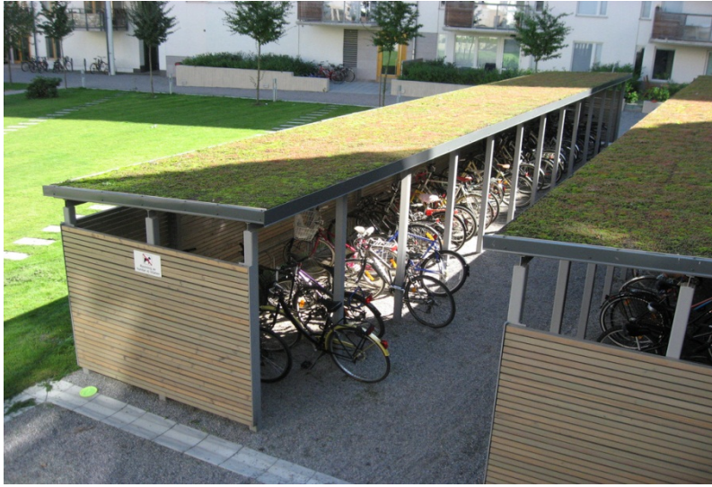
Fig. 158 - Espaço para arrumação de bicicletas no logradouro de um edifício de habitação.
