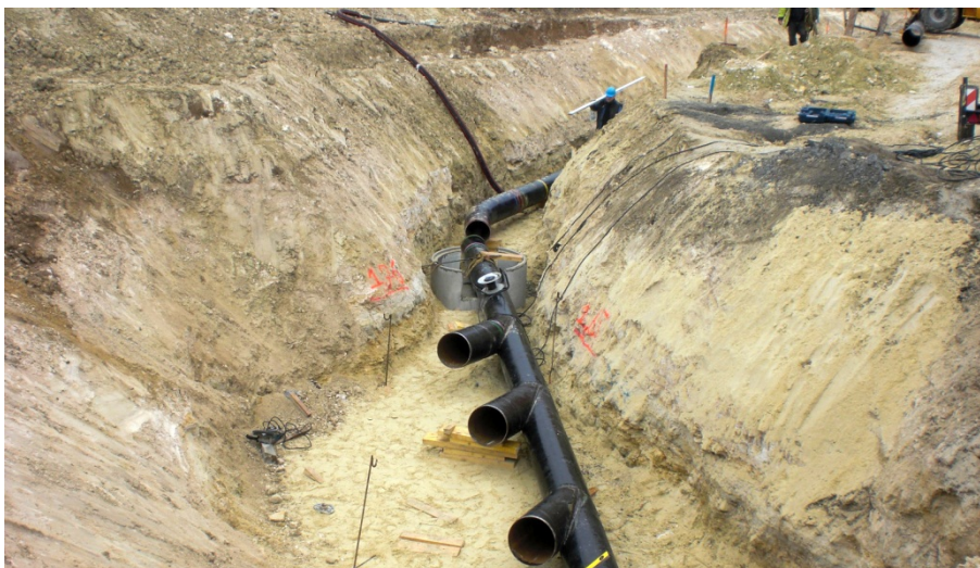
Fig. 120 - Instalação das condutas de aço carbono em vala.
