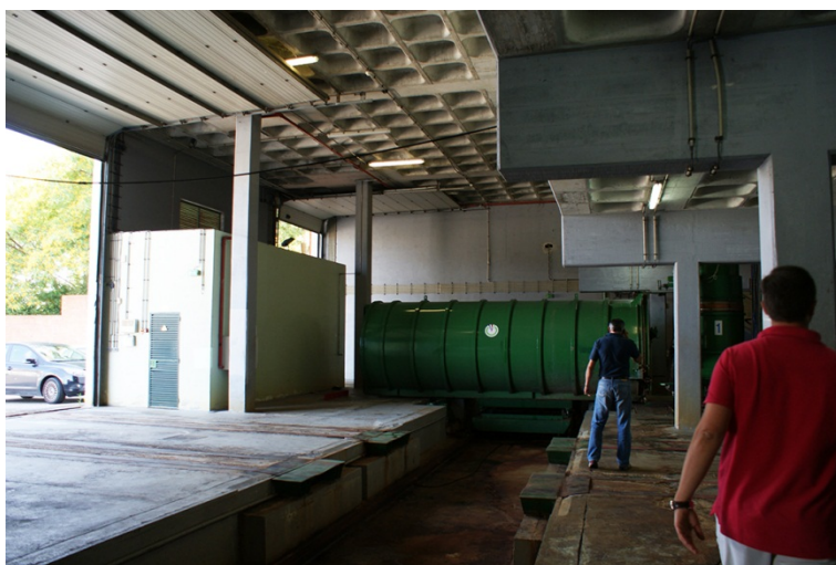
Vista interior da zona de acoplagem e manobra dos contentores.
