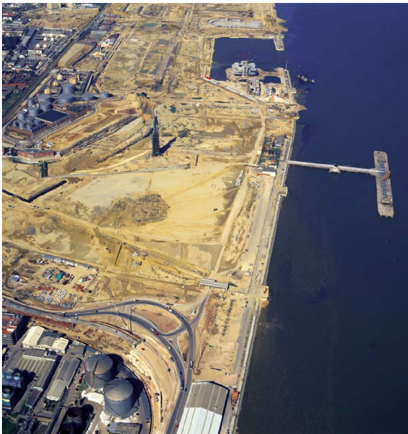
Fig. 50 - O terreno após as operações de desocupação e limpeza.
