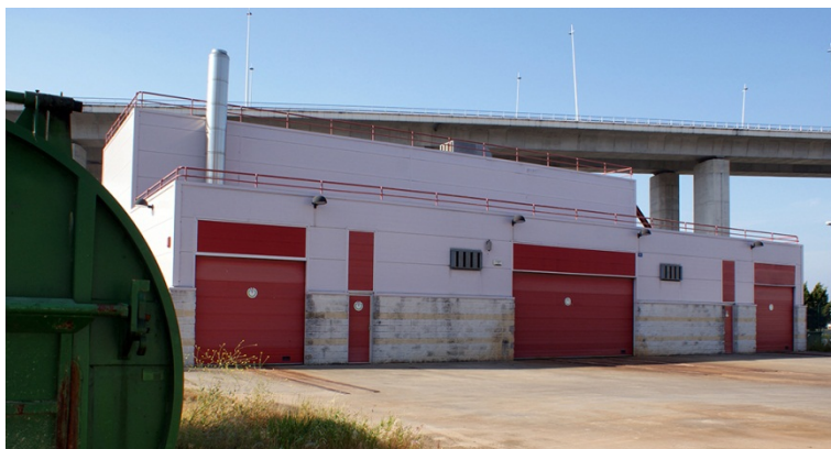
Vista da zona de entrada do edifício.
