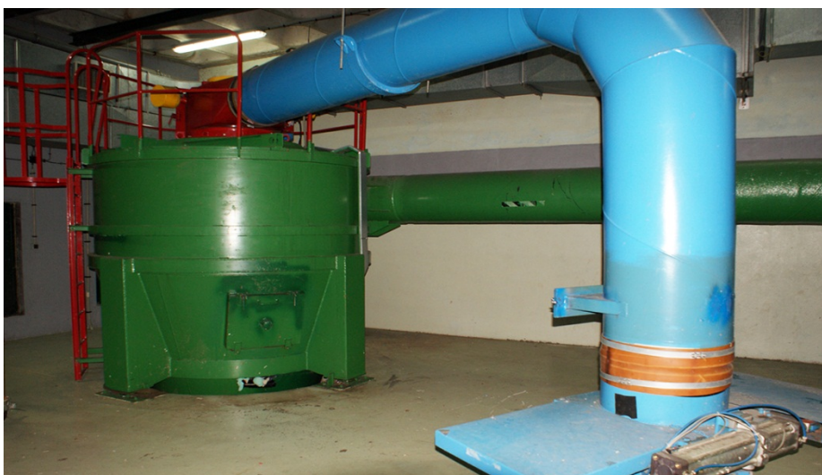
Fig. 123 - Ciclone que possibilita a separação dos resíduos do ar de arrastamento.
