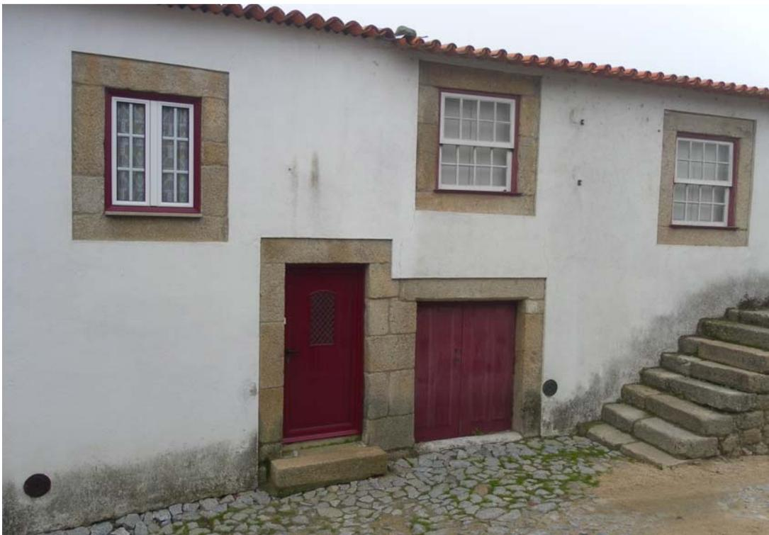
Exemplos de caixilhariadas usadas na intervenção do PRAHP e novas caixilhariadas entretanto colocadas,
