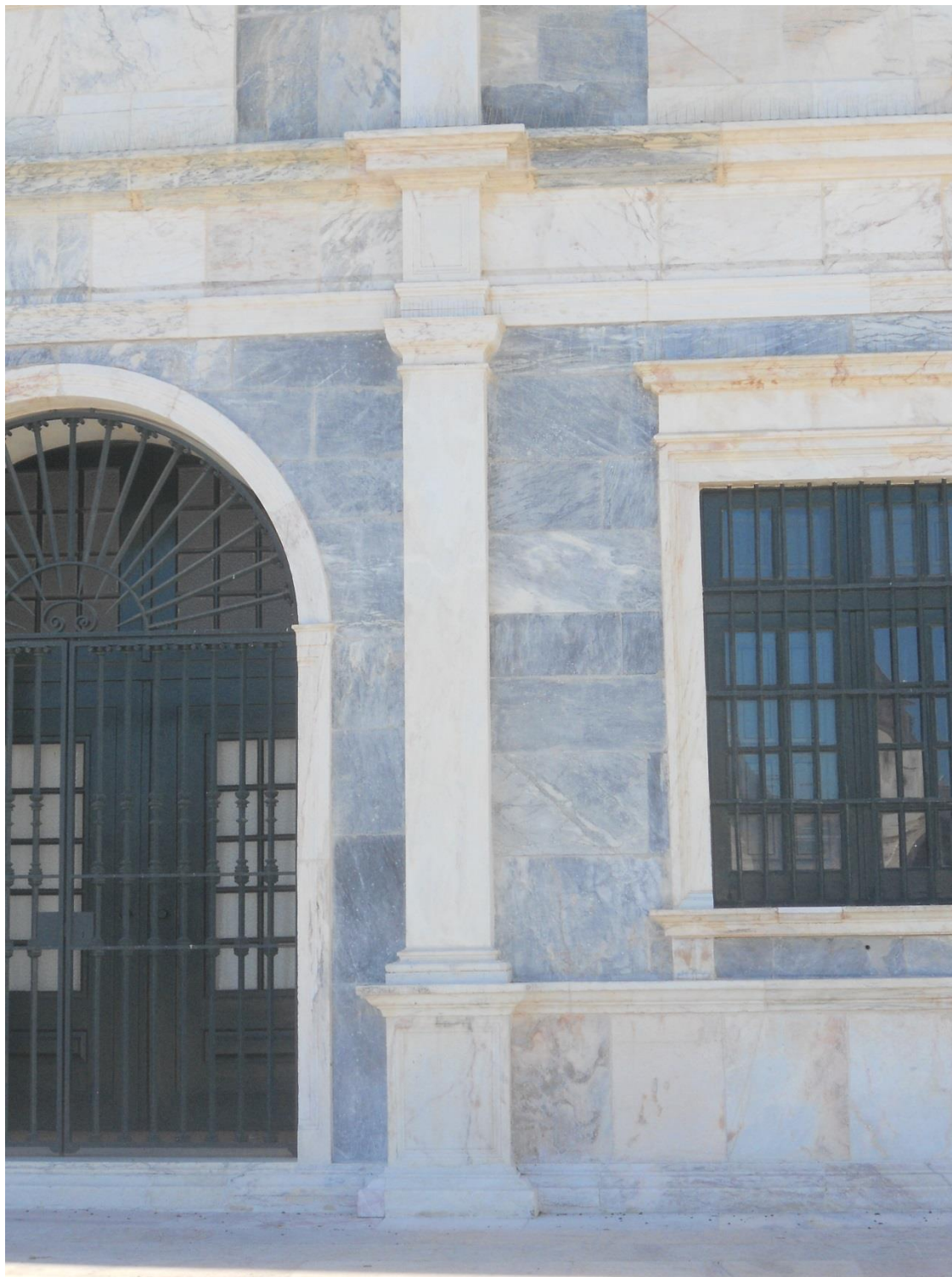
Figura 6. Palácio Ducal de Vila Viçosa. Pilastra sobre pedestal, com variação de base dórica, capitel dórico e entablamento dórico.
