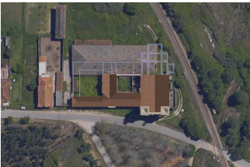
Imagem 6 – Reconstituição do existente sobre imagem aérea, com base na Carta de Risco do Património – Mosteiro de Santa Maria de Seixa – DGEMN
