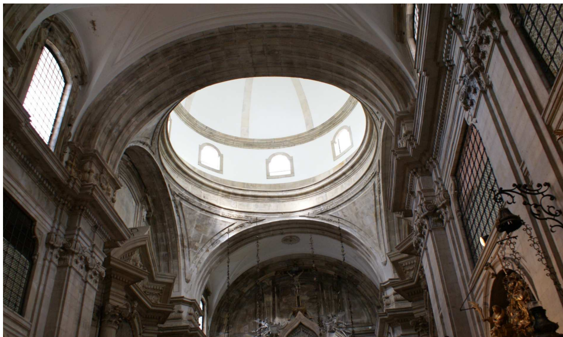
Imagem 19 – Pormenor da abóbada da Igreja do Mosteiro de Lorvão, Sílvio Gaspar, 2010
