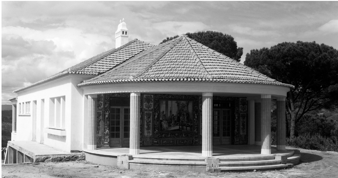
Fig. 64 - Casa da Criança dos Olivais, em fase final de construção.
