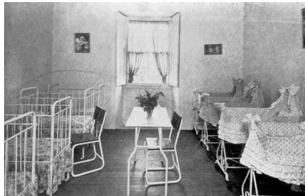
Fig. 121 - Vista de espaço interior da antiga Casa da Mãe.
