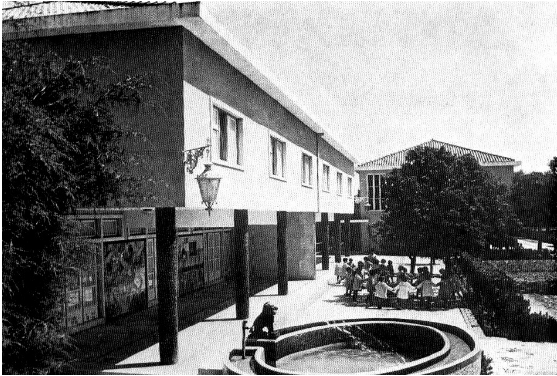
Fig. 177 - Vista de um Bloco de Dormitórios, na sua forma original.
