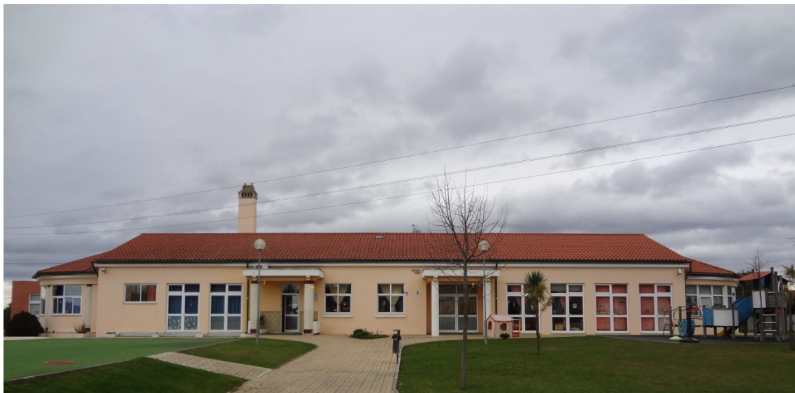
Fig. 133 - Perspectiva actual da Casa da Criança da Mealhada, após significativa ampliação e fortes alterações.
