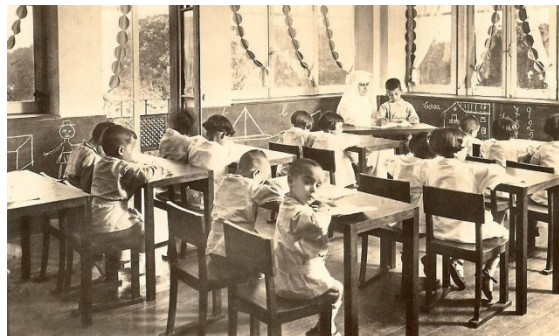
Fig. 38 - Preventório de Penacova (sala de aula).
