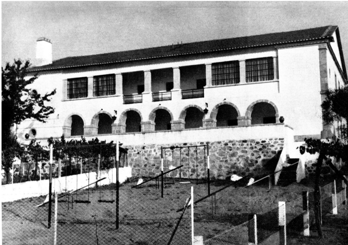
Fig. 164 - Vista, a partir do recreio exterior, da Colónia Ar Alto.
