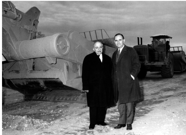
Fig. 82- Bissaya Barreto com Júlio Araújo Vieira (Presidente da Câmara Municipal de Coimbra), durante as obras do Aeródromo de Cernache.
