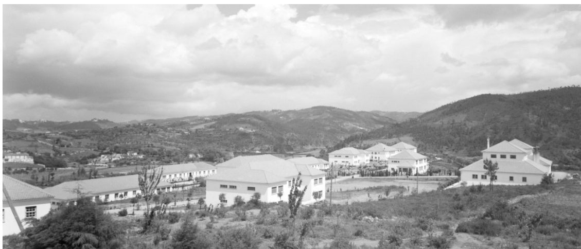
Fig. 85 - Vista geral, desde o acesso principal ao terreno, do Hospital Sobral Cid.
