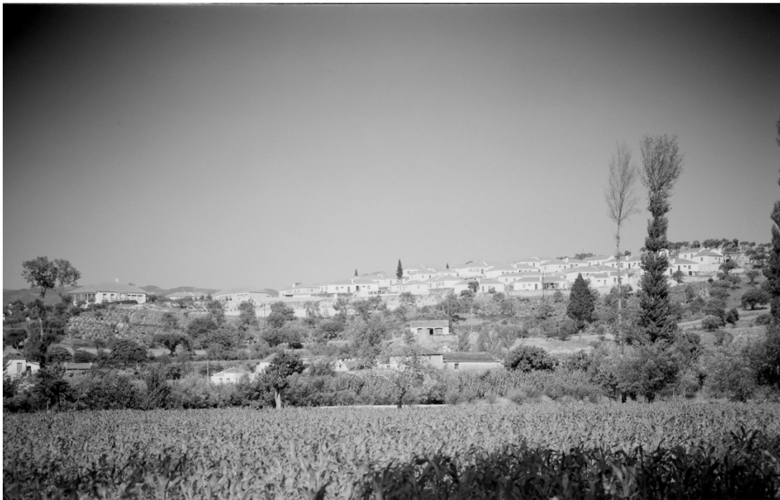
Fig. 77 - Vista geral, desde poente, do Bairro do Loreto.
