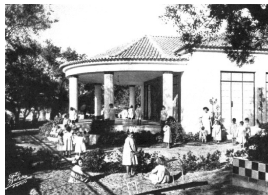
Fig. 132 - Vista do coberto semi-circular da Casa da Criança da Mealhada, desde o jardim.
