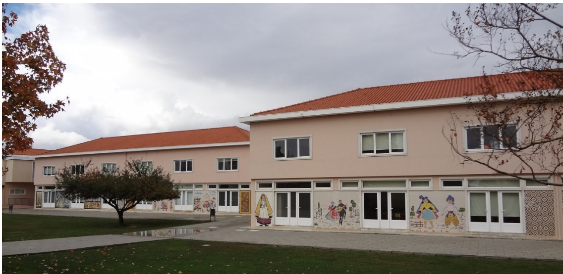
Fig. 178 - Vista exterior, na actualidade, dos antigos Blocos de Dormitórios (actuais Sala de Aula do Colégio Bissaya Barreto).
