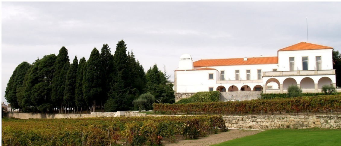
Fig. 162 - Unidade hoteleira actualmente instalada no edifício onde funcionou a Colónia Ar e Sol.
