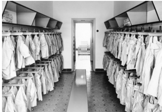
Fig. 136 - Vestiário da Casa da Criança de Albergaria-a-Velha.
