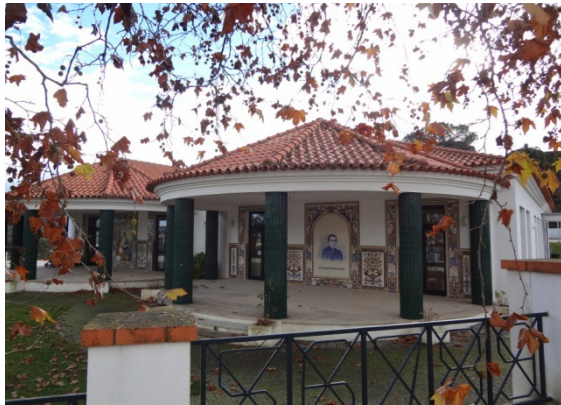
Fig. 125 - Vista actual da Casa da Criança de Arganil, após a significativa ampliação.
