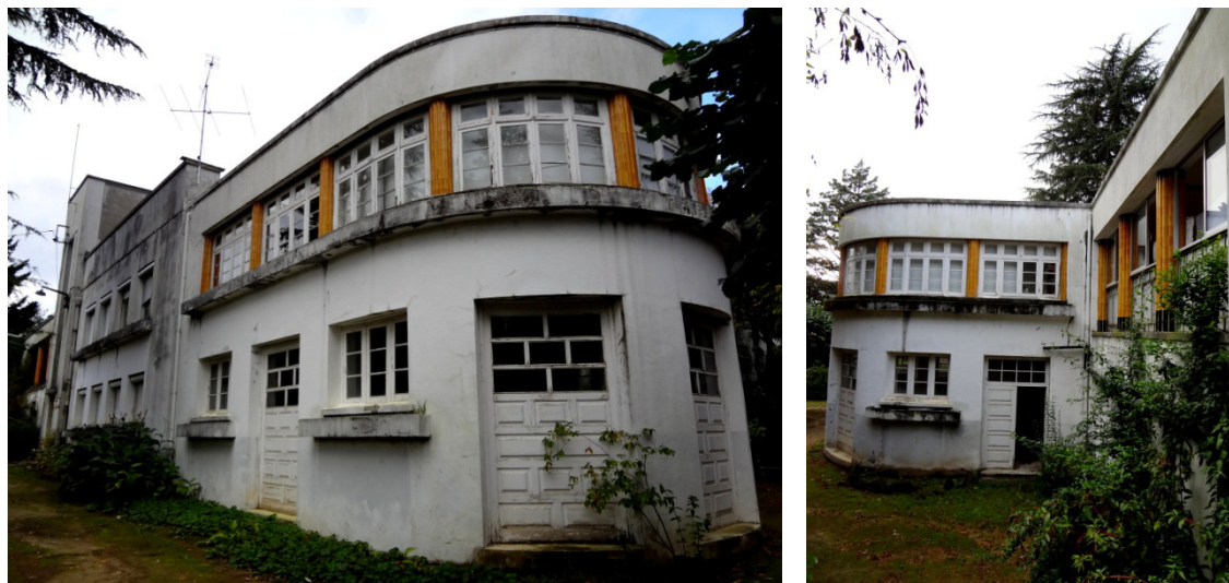
Fig. 61 - Vistas actuais do edifício de Internato de Castanheira de Pêra.
