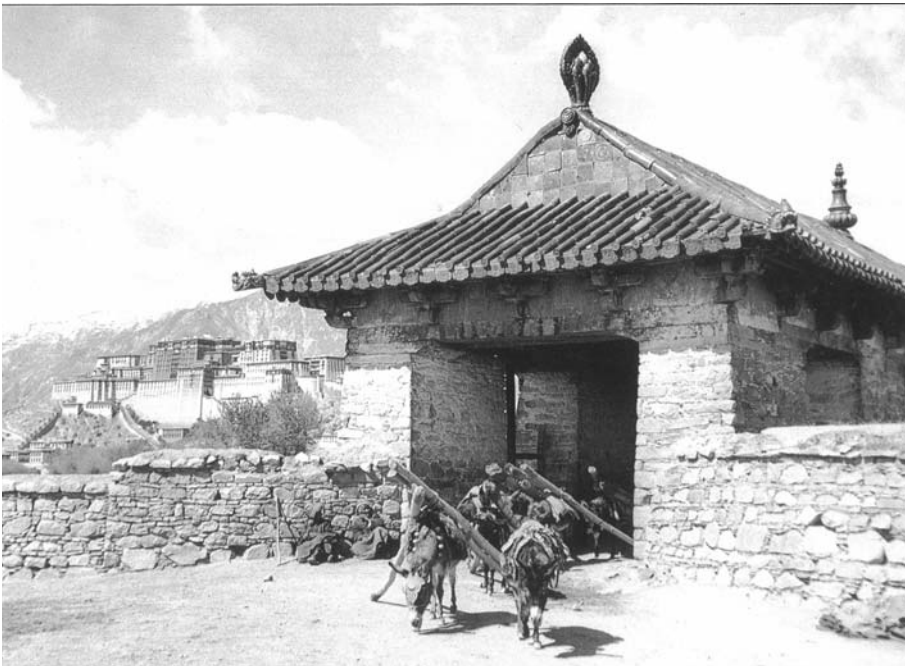
I 97 Ponte Yutok Zampa, antes da intervenção.
