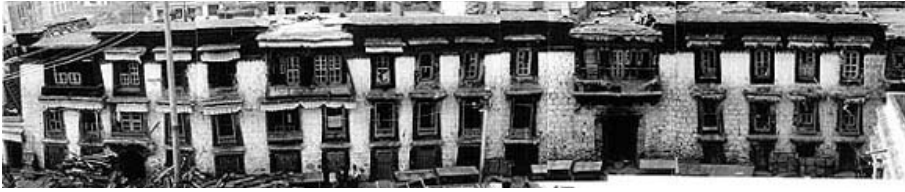
I 95 Edifício Tromsikhang, antes da demolição.
