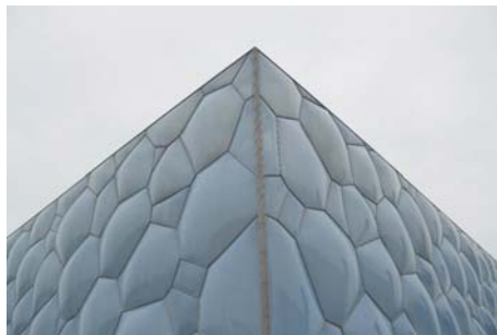
Texturas da fachada das piscinas olímpicas, Pequim.
