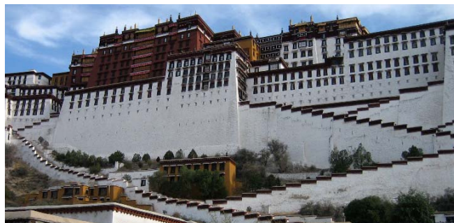
I 144 Palácio Potala. 'Zig-zag' de escadas marcadas por muros de suporte em escadinha.
