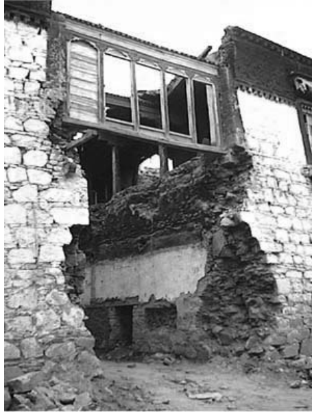
I 96 Edifício Tromsikhang, durante a demolição em 1997.
