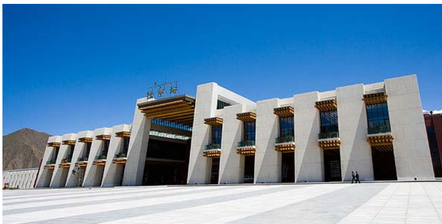
I 104 Estação Ferroviária de Lhasa.
