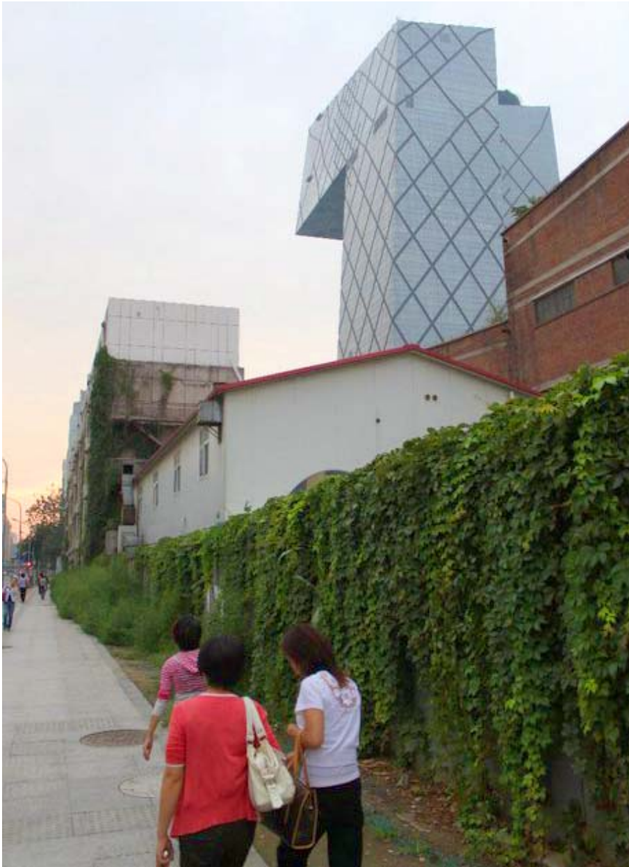
CCTV, OMA, Pequim. Confronto evidente entre a nova cidade e as infraestruturas pré- existentes.
