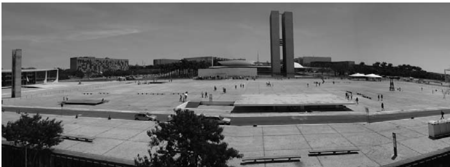
I 36 Praça dos Três Poderes, Lúcio Costa (Plano) e Oscar Niemeyer (Edifícios), Brasília.
