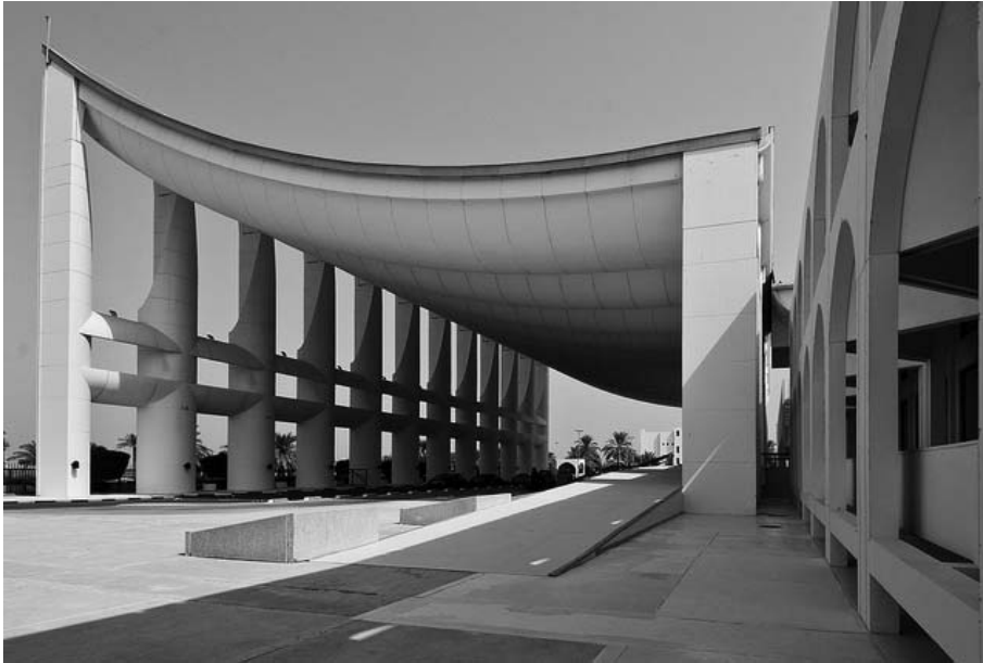
I 59 Assembleia Nacional do Kuwait. Vista da praça coberta.
