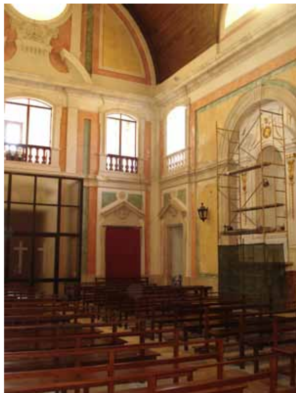
Figura 34: interior da igreja (à direita, trabalhos de conservação e restauro num dos altares laterais), 2013.
