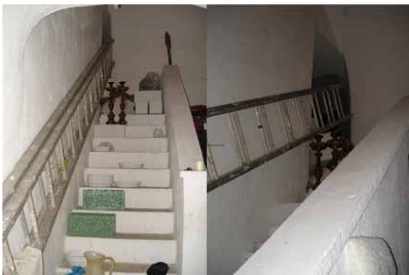
Figura 35: Escada em compartimento contíguo à nave da igreja, 2013.
