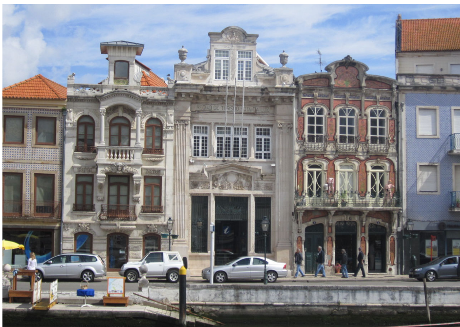
Figura 53: Edifícios de estilo Arte Nova em Aveiro
