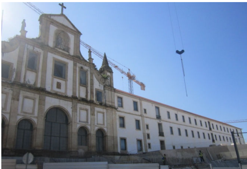
Figura 86: Futuro Centro de Convenções e Espaço Cultural do Convento São Francisco
