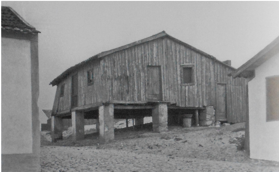
8 | Elevação dos palheiros como forma de protecção dos ventos e areia.
