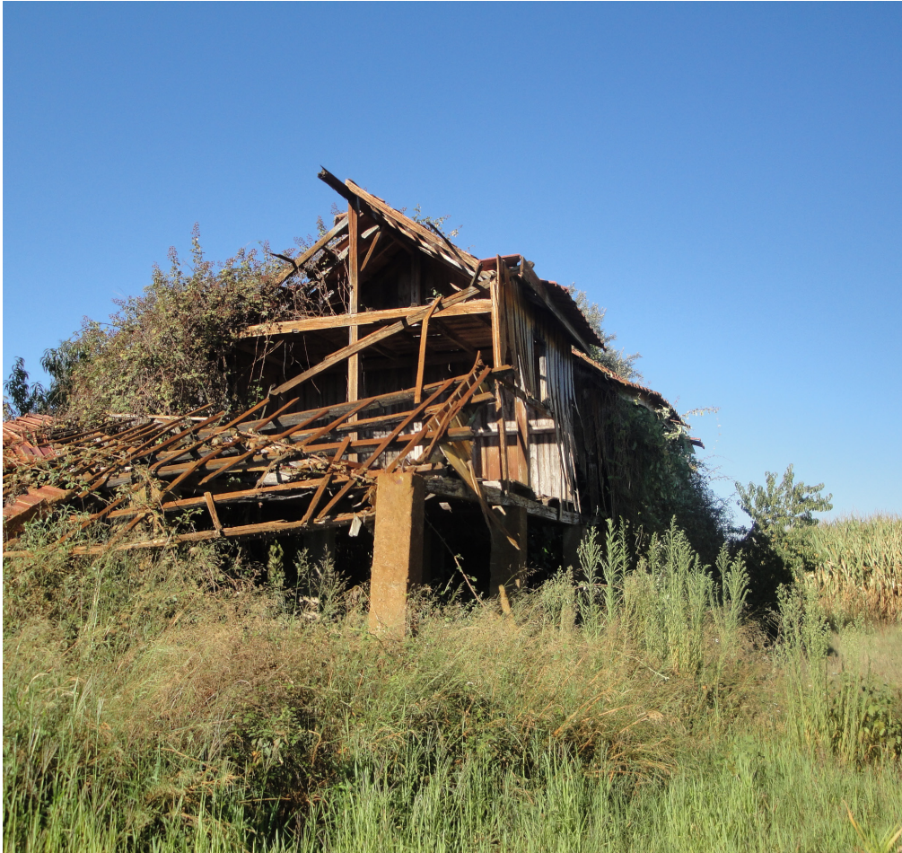
61 - Núcleo 1: Aspecto preocupante da degradação das habitações.
