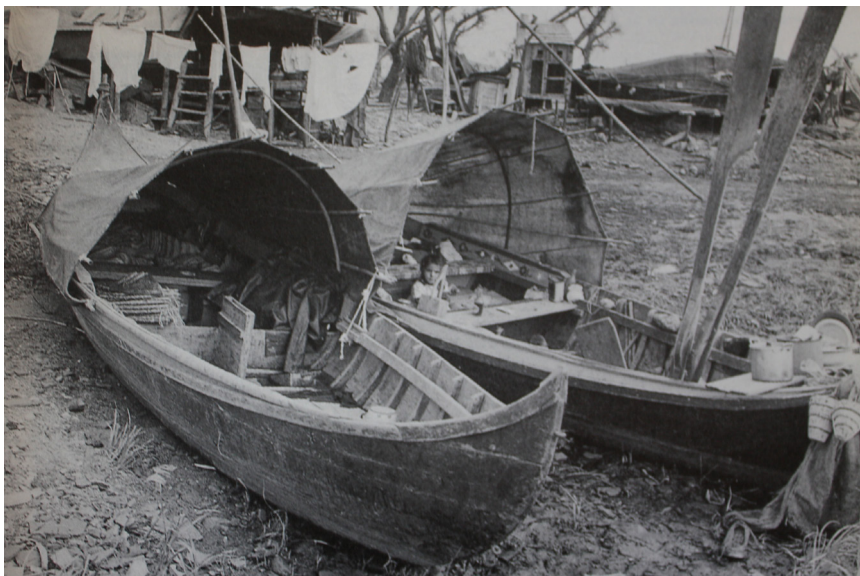
16 - Barco Avieiro transformado em casa provisória.
