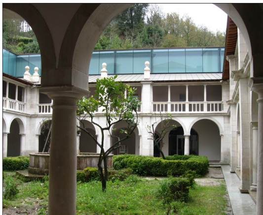
Figura 121. Claustro do silêncio, com as obras de adaptação a museu quase terminadas, 2013
