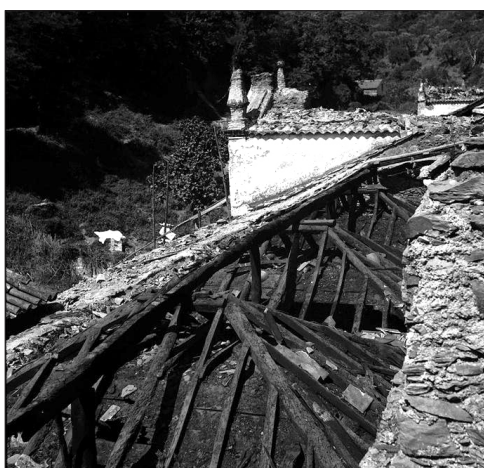
Figura 101. Telhado do dormitório, antes das obras
