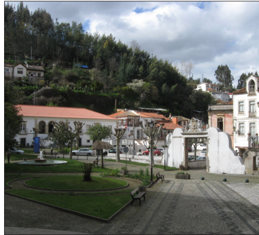
Figura 41. Antiga porta do pátio vista do jardim público do mosteiro, atualmente
