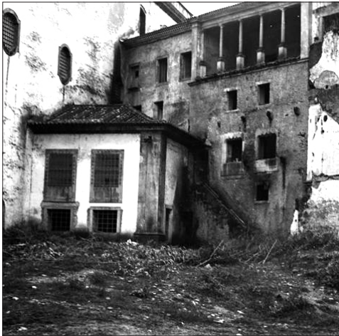
Figura 77. Alçado nascente, onde é visível a antiga escada de acesso à enfermaria e cartório
