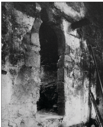
Figura 19. Porta monçárabe, antes das obras de restauro de 1940
