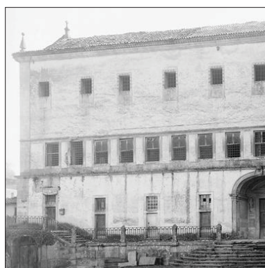
Figura 47. Mosteiro de Lorvão, parte da fachada dos locutórios, 1930
