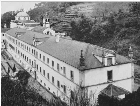
Figura 106. Conjunto monástico, depois das obras
