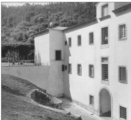
Figura 113. Terrenos a sul do antigo dormitório, depois das obras
