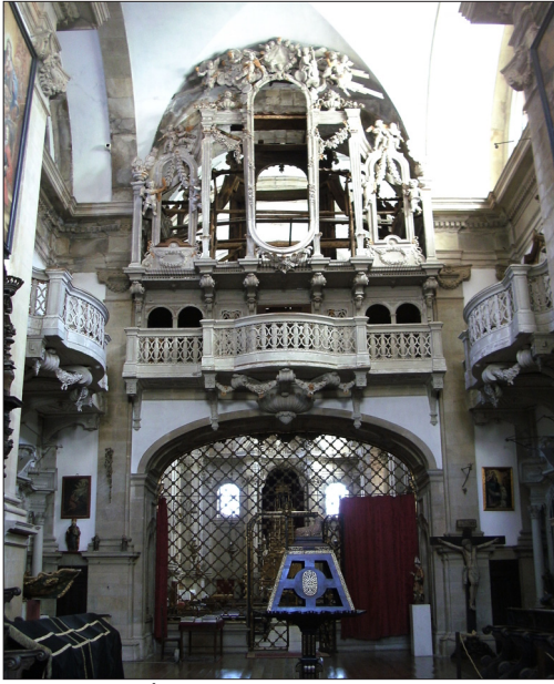
Figura 119. Órgão da igreja de Lorvão durante as obras de restauro, 2012
