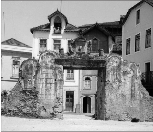
Figura 40. Porta do pátio vista do adro do mosteiro, antes das obras de restauro de 1940
