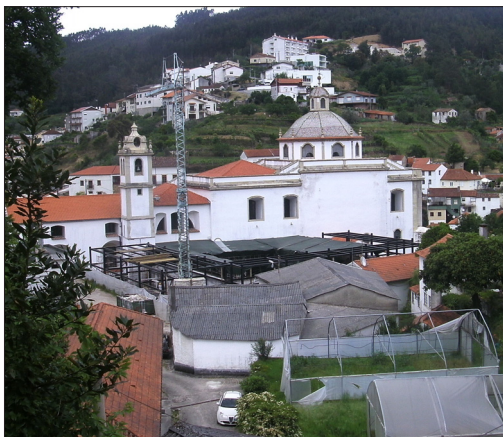
Figura 120. Claustro do silêncio de Lorvão durante as escavações e obras de adaptação a museu, 2012
