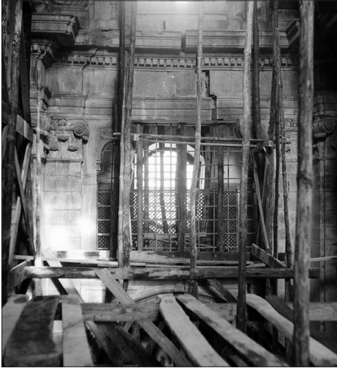
Figura 103. Interior da igreja, durante as obras de reparação da estrutura
