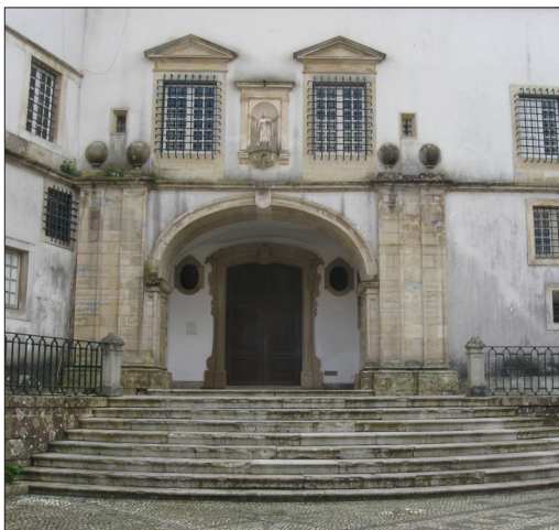
Figura 68. Portaria de acesso à igreja, atualmente
