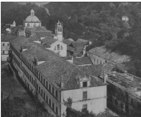
Figura 105. Conjunto monástico, antes das obras
