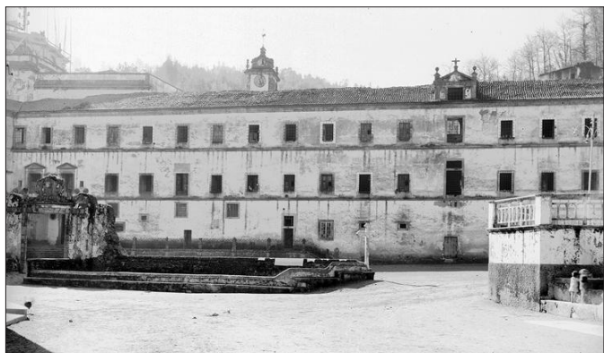
Figura 63. Dormitório visto do burgo, antes das obras de 1940
