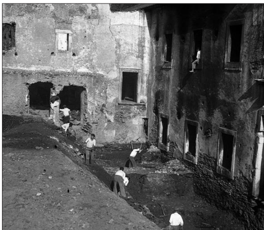
Figura 112. Terrenos a sul do antigo dormitório, durante as obras
