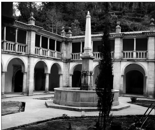
Figura 57. Claustro do silêncio onde são visíveis as capelas no piso térreo, 1957
