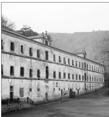
Figura 64. Alçado norte do dormitório, antes das obras de 1940
