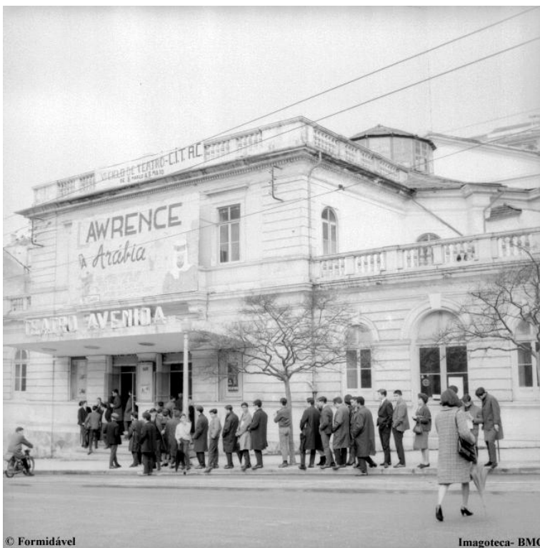
Fachada Principal do Teatro Avenida. Vista desde a Avenida Sá da Bandeira. [Fm_04951– cedida pela Imagoteca da Biblioteca Municipal de Coimbra].
