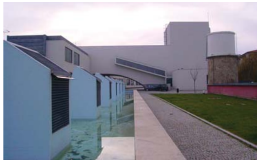
Rua - Tanque de Água
