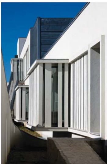
Janelas de "luz riscada"
