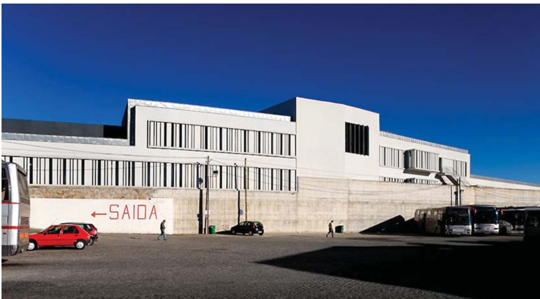
Edifício a Nascente
