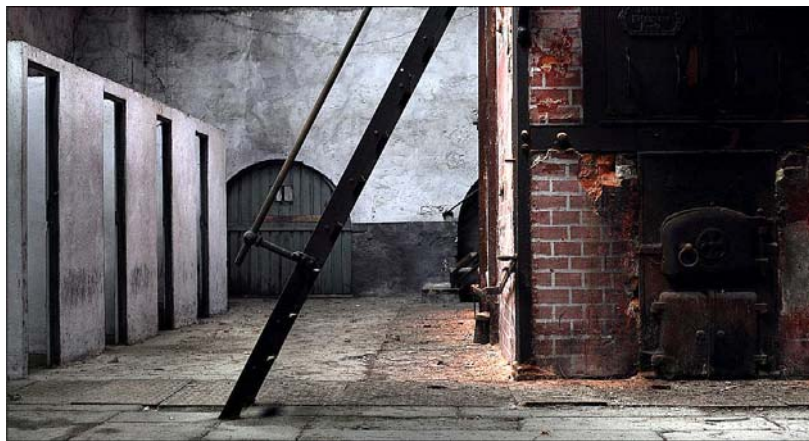
Vista da base da chaminé
