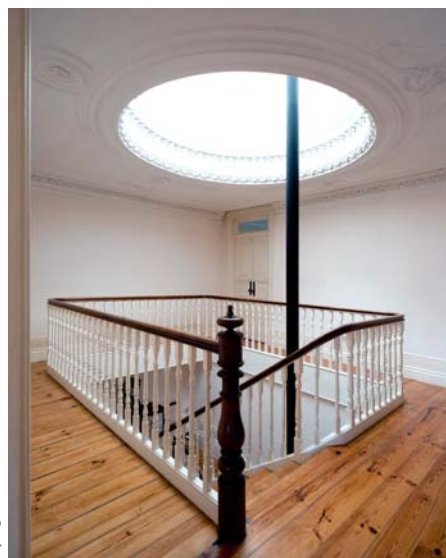
Vista da clarabóia no piso superior
