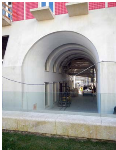
Vistado acesso ao Largo dos Lóios a partir do interior do quarteirão
