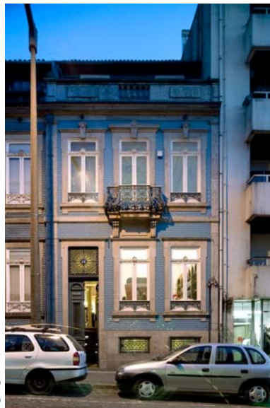
Fotografias das fachadas do edifício
