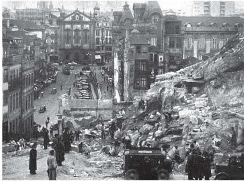
Obras de abertura da Avenida da ponte – década de 1940
