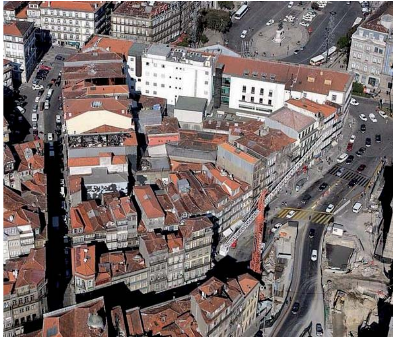
Vista aérea do quarteirão antes do começo dos trabalhos
