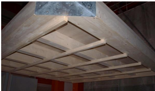
a) Vista inferior do provete sem o revestimento.
