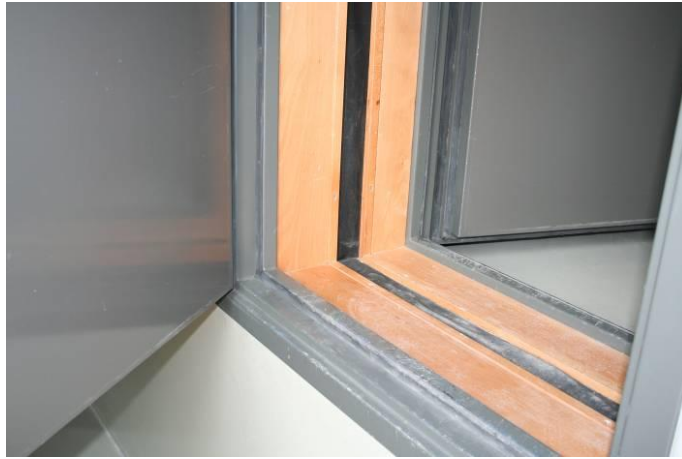
Figura 4.3 - Pormenor das portas de acesso ao interior da câmara fixa.
