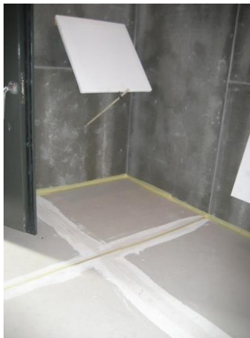
a) Provete instalado nas câmaras verticais.
