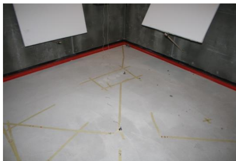
b) Posição dos acelerómetros na laje de referência.
