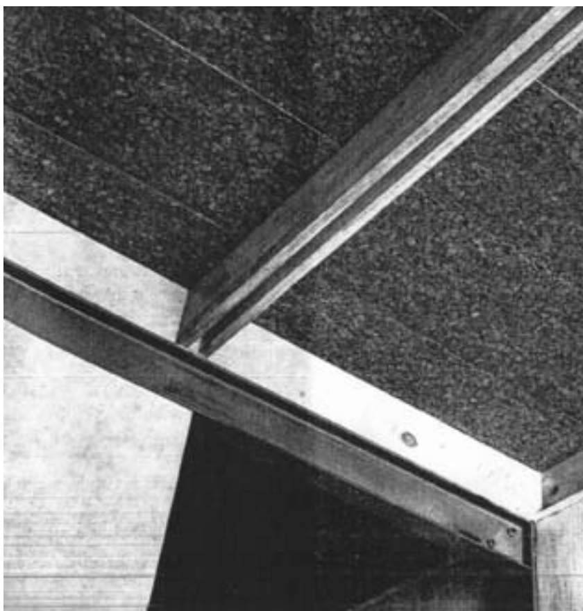
Hotel de Porto Santo Sistema Construtivo Eduardo Anahory e Pedro Cid, 1960-1962 (imagem ANAHORY, Eduardo, “Hotel de Porto Santo”, Binário , Lisboa, N.º 88, Janeiro 1966, p. 31)
