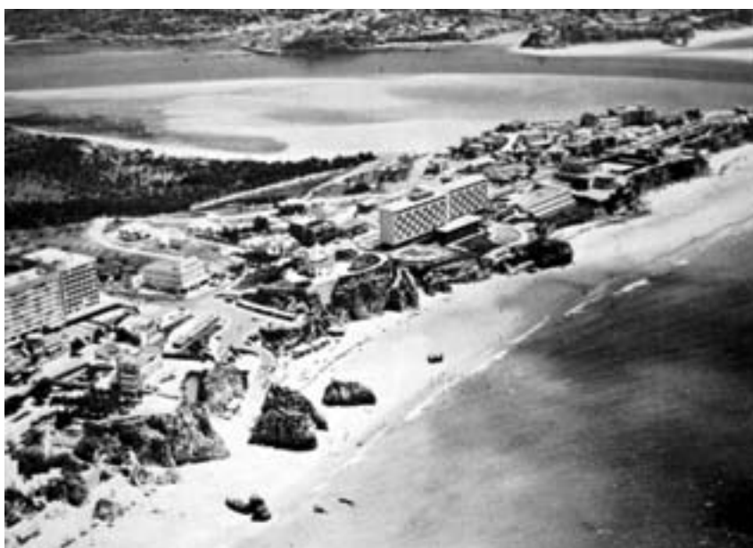
Hotel Algarve, Praia da Rocha Fotografia Aérea, c.1967 (imagem “O Hotel Algarve na Praia da Rocha”, Arquitectura , Lisboa, IV Série, N.º 97, Maio-Junho 1967, p. 100)
