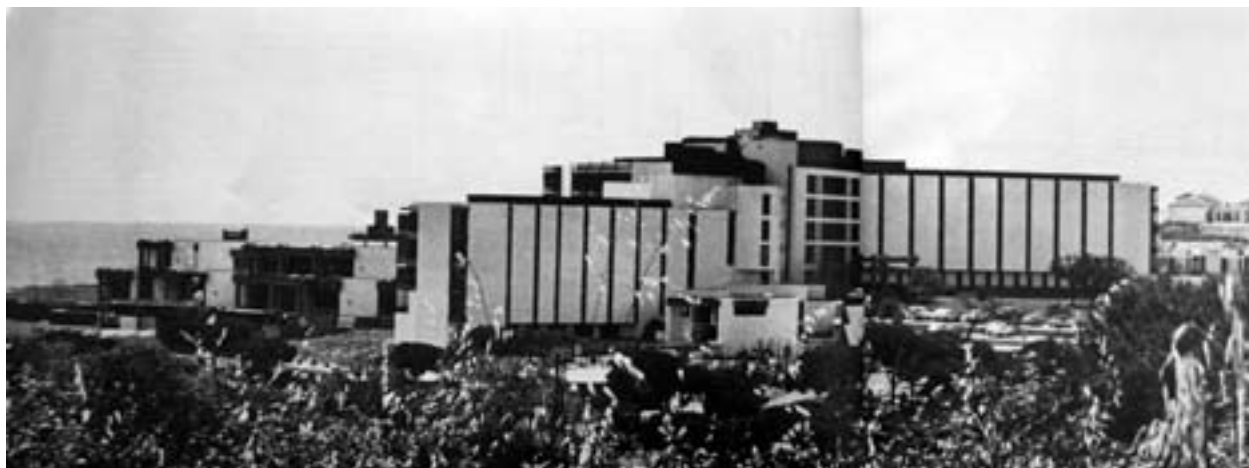
Hotel da Balaia, Albufeira Vista do alçado de entrada Fotografia, 1968
