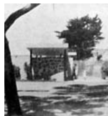
Piscinas do Tamariz, Estoril Entrada (vista do interior e do exterior) Fotografias, c.1958 (imagens TAÍNHA, Manuel, "Piscina no Tamariz", Binário , Lisboa, N.º 3, Junho 1958, p. 9)
