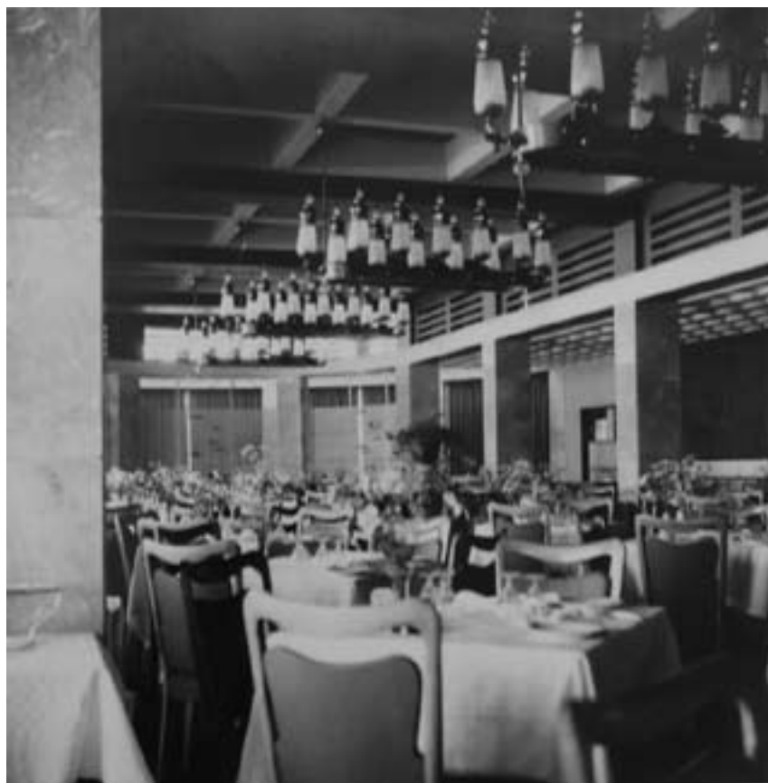
Grande Hotel da Figueira da Foz Sala de Jantar Fotografia, 1955 (imagem Arquivo Turismo de Portugal)
