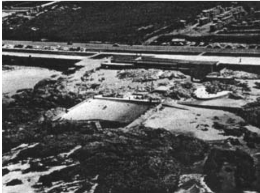
Piscinas de Marés, Leça da Palmeira Vista Aérea Fotografia, c.1967 (imagem ALMEIDA, Pedro Vieira de, “Uma análise da obra de Siza Vieira: Piscina de Leça em Matosinhos (Porto)”, Arquitectura , Lisboa, III Série, N.º 96, Março-Abril 1967, p. 73)
