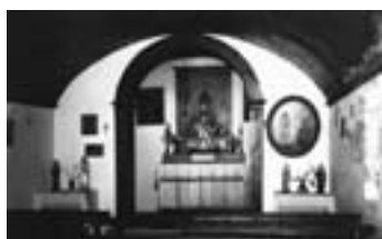
S. Pedro de Muel Capela de Nossa Senhora da Piedade Fachada e Interior Fotografias, 1954 (imagens www.mgrande.net )
