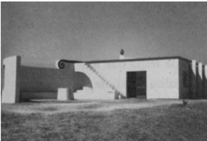
Casa-Abrigo em Alporchinhos, Senhora da Rocha (Algarve)
