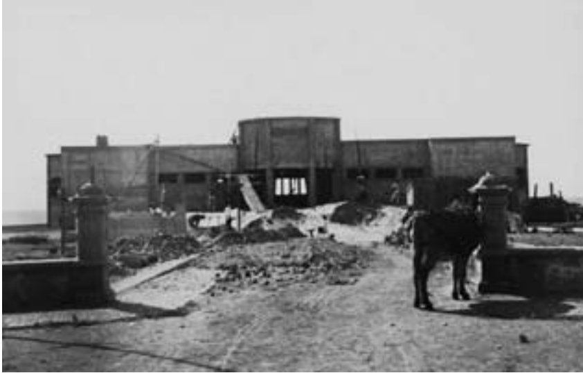
Casino de Monte Gordo Fotografias da fase de construção, c. 1934 (imagens Espólio Luís Cristino da Silva/Biblioteca de Arte FCG)
