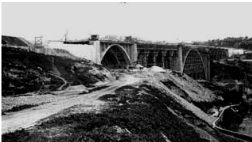
Construção do Viaduto de Alcântara Fotografia, 1943 (imagem Arquivo Municipal de Lisboa/ Arquivos Fotográficos/Espólio Eduardo Portugal)
