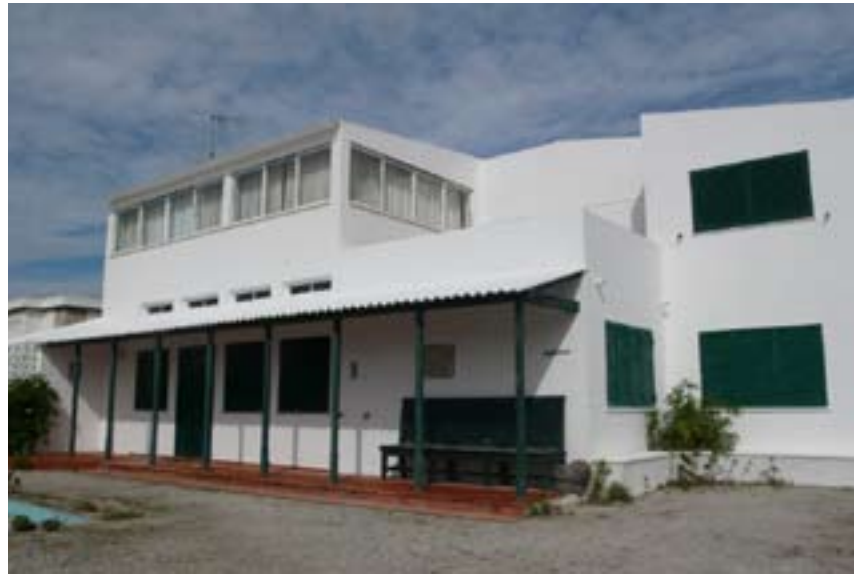
Casa Joaquim Emídio de Oliveira Correia, S. Pedro de Moel Fotografia da autora e Plantas e Alçados (Escala 1:200) Jorge Barradas Correia, 1956-1957 (imagens Arquivo Municipal da Marinha Grande)
