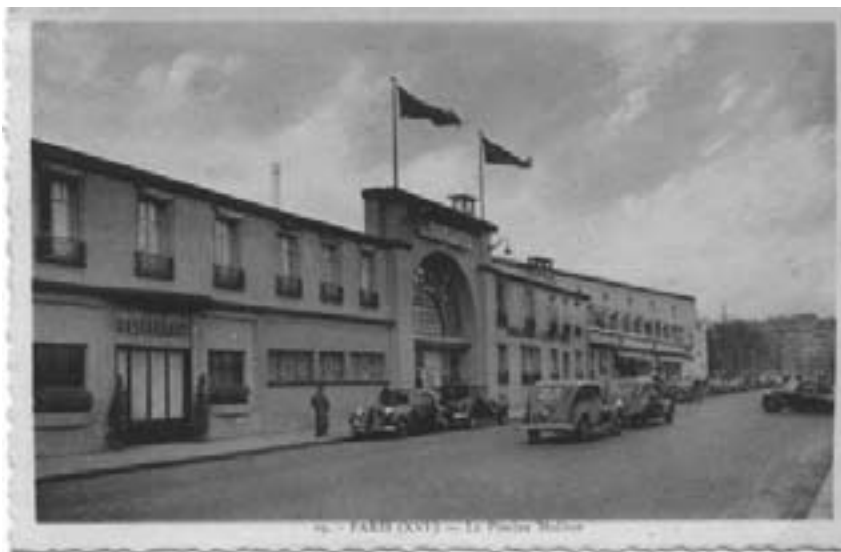
Paris - La Piscine Molitor (Fachada Sul) Bilhete Postal, c.1929 (imagem www.piscine-molitor.com )
