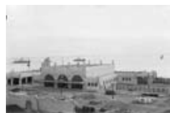
Estação Fluvial Sul e Sueste Fotografia c. 1931 (imagem www.arquivomunicipal.cm-lisboa.pt )
