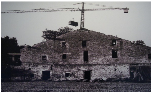
Fig 250. Ruína de Zabalaga antes do restauro de Chillida
