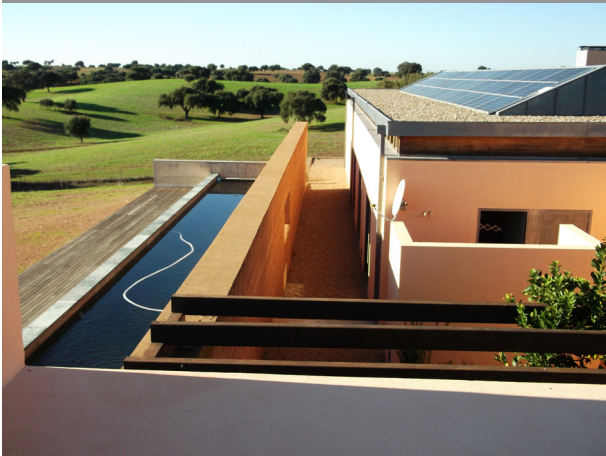
25. Habitação em Salvada - proteção superior do muro de taipa
