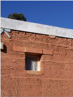
77. Caldeirinha - lintel de betão
