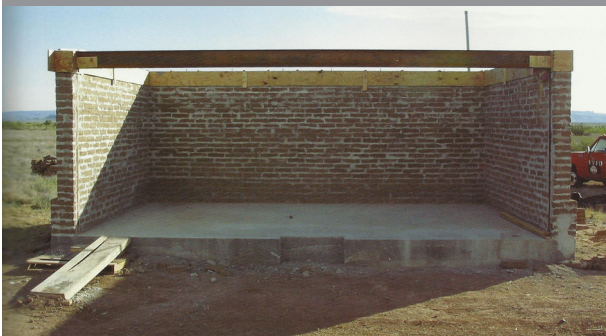
57. Construção em adobe e cimento, tal como Donald Judd
