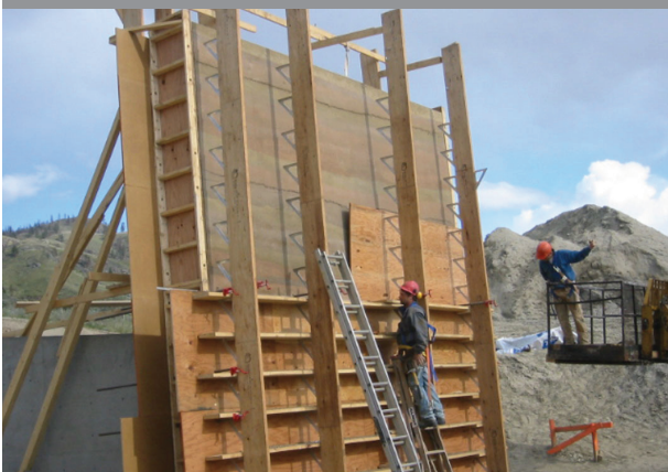
18. Cofragem de desenvolvimento vertical
