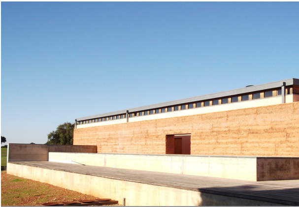
27. Habitação em Salvada - taipa estabilizada à superfície
