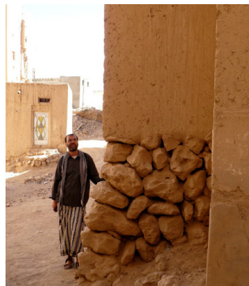
15. Fundação de pedra a seco em Wadi Do'na
