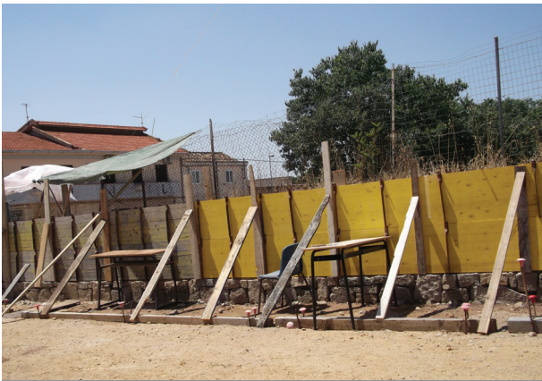
17. Cofragem a tod o comprimento , muro em taipa na Sardenha
