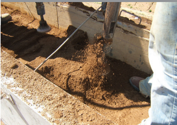
21. Compactadores pneumáticos
