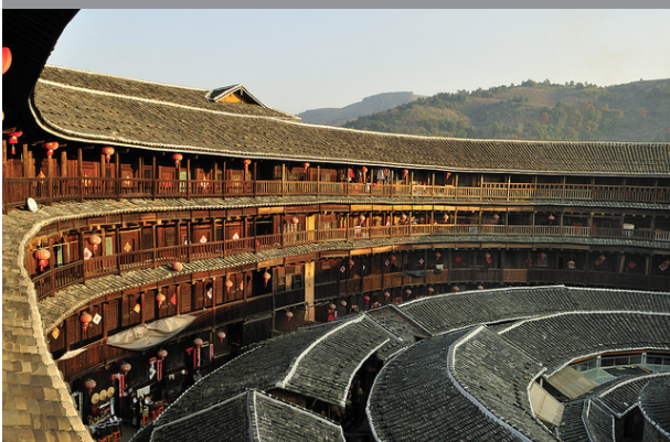
7. Estrutura de madeira interior de um edifício circular
