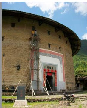
10. Estudo da fissuração
