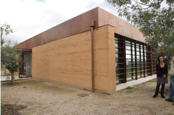
24. E.T.A.R. de Évora - embasamento inexpressivo
