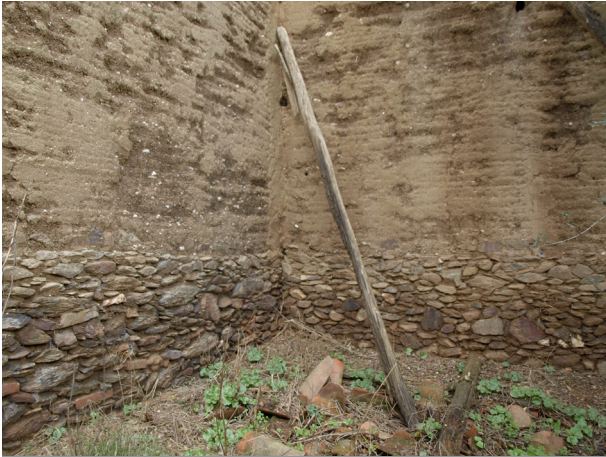
26. Embasamento de pedra - ruina no Alentejo, 2012
