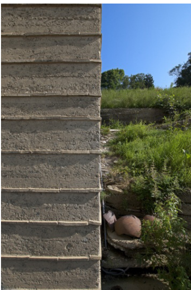
48. Elementos horizontais, terra granular
