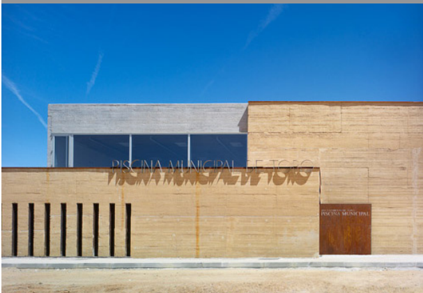
29. Piscina Municipal de Toro em Espanha, 2007
