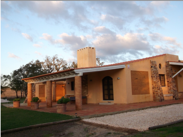
22. Cerro da Borrega - cobertura, embasamento e reboco
