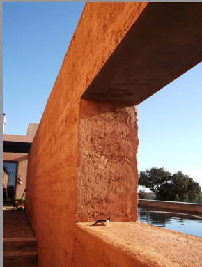
81. Hab. em Salvada - lintel em aço
