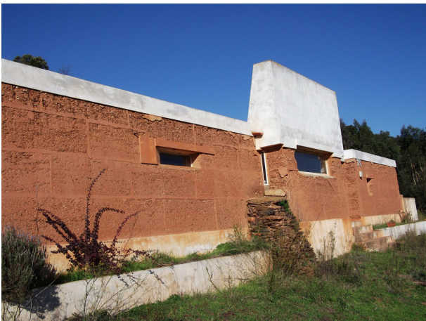
23. Caldeirinha - embasamento e proteção superior
