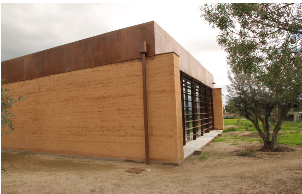
95. E.T.A.R. de Évora - parede onde os reforços internos são visíveis
