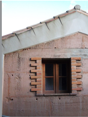
78. Casas da Cerca - lintel de betão
