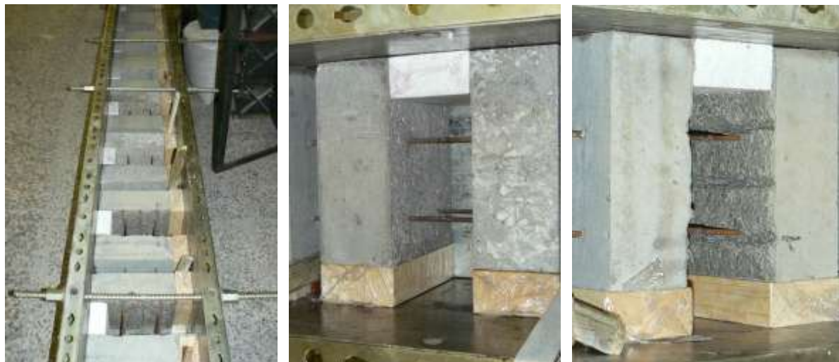
Figura 7.33 – Cofragem dos provetes de duplo corte, com armadura na interface.
