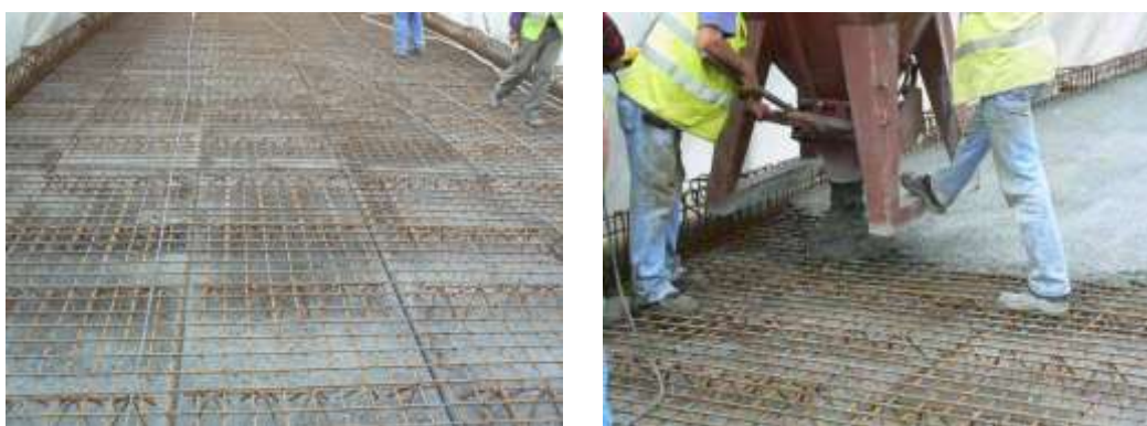
Figura 2.29 – Colocação de BEAL em obra (reforço da ponte do Fão).
