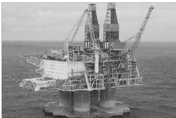
Figura 2.11 – Plataforma offshore Hibernia [75].
