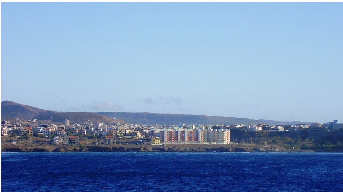
Figura 1.2 - Edificação na orla costeira (Cidade da Praia).
