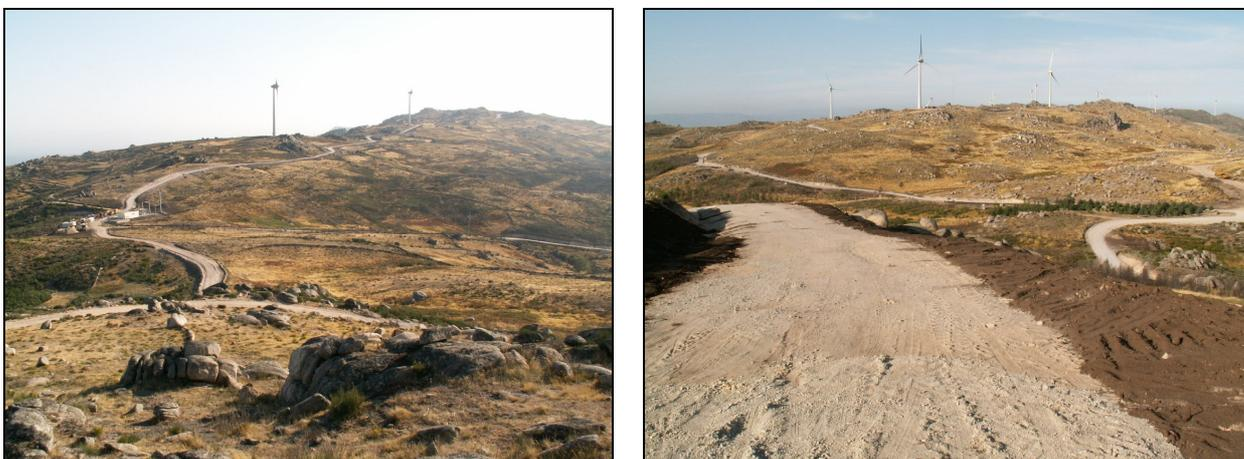
**Figura 4.7. Acessos de ligação entre os aerogeradores e destes com os edifícios de comando do sub parque eólico de Silvares/Carvalho da Mulher.**
