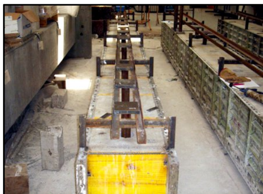
g) Colocação das micro-estacas nos furos
