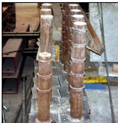
d) Aspetto final das micro-estacas
