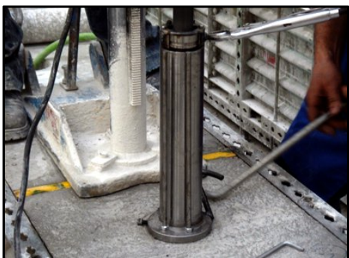
e) Tratamento dos furos - denteação
