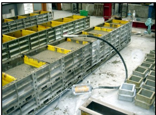
c) Betonagem dos Blocos e provetes
