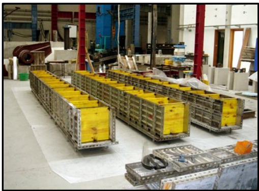
a) Montagem das cofragens
