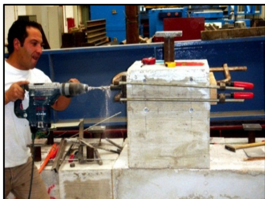
k) Abertura de furos e colocação dos varões Dywidag para o confinamento dos blocos
