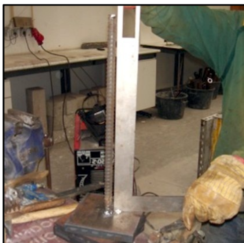
a) Soldadura do varão Dywidag
