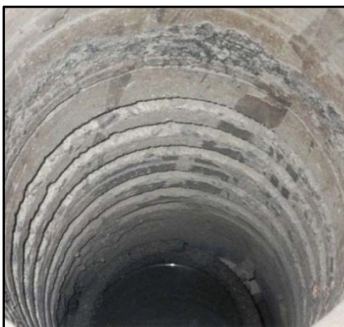
c) Superfície indentada: sistema Ankerbond , (Richards e Bruce, 2004)
