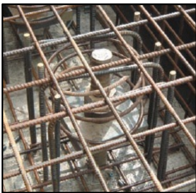
a) Micro-estaca comprimida – solução para varão isolado
