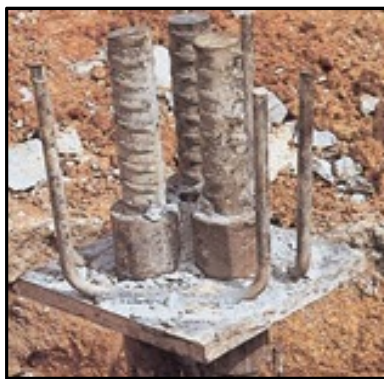
a) Micro-estaca comprimida – solução multi-varões
