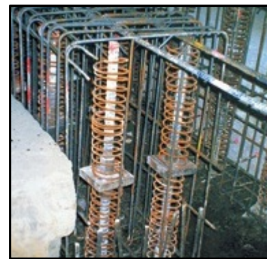
c) Micro-estaca comprimida / tracionada
