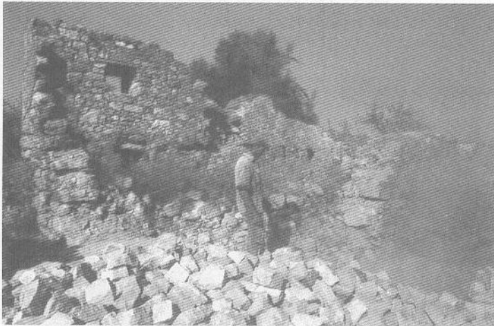
Foto 2 – As casas antigas são, em geral, boas... “pedreiras” à mão de semear. Na foto, o casal salão de Freiria a ser transformado em paralelepípedos. Os arqueólogos identificaram nos escombros fustes de colunas romanas reutilizadas. [Foto de Guilherme Cardoso].
