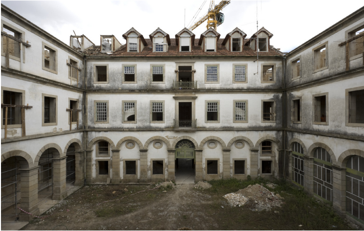
F90. F91. F92. F93. Processo de obra.
