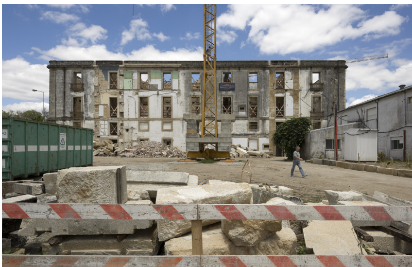
F89. Processo de obra, fachada sul.
