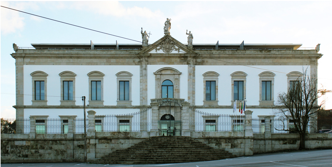
F1o9. Fachada principal.
