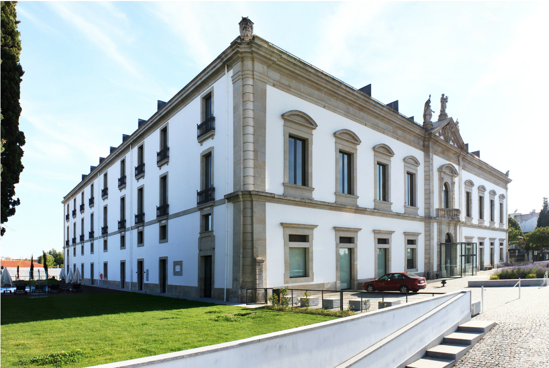
F98. Exterior, lado nascente e sul.
