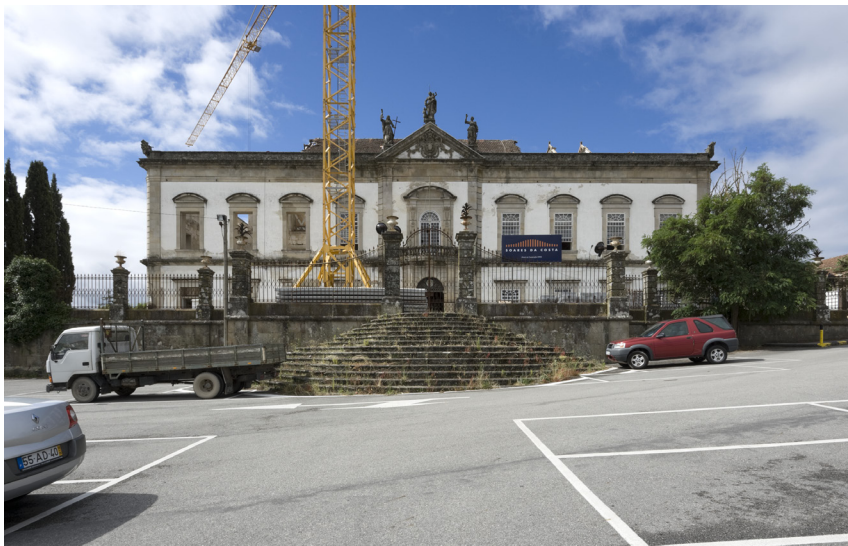
F88. Processo de obra, fachada principal.
