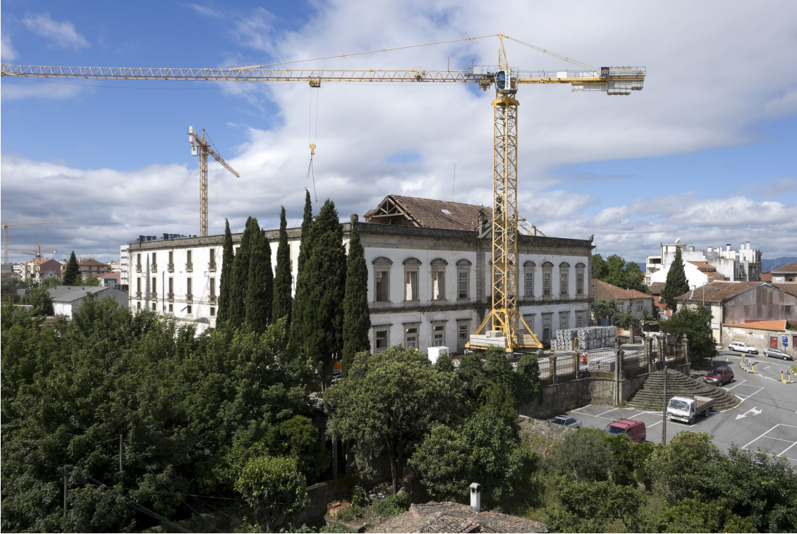
F97. Processo de obra.
