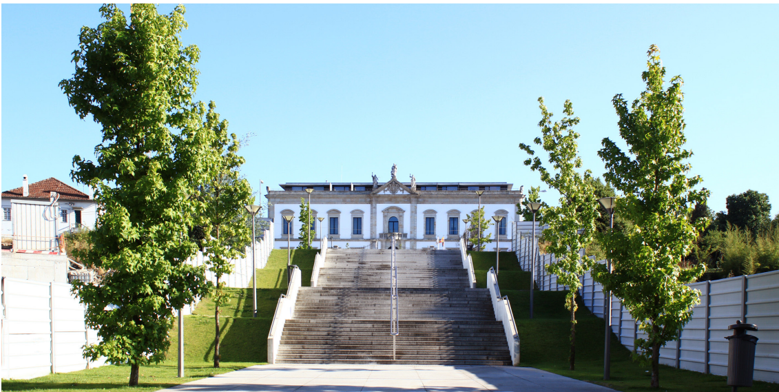
Fig. 2. Acesso à Pousada.
