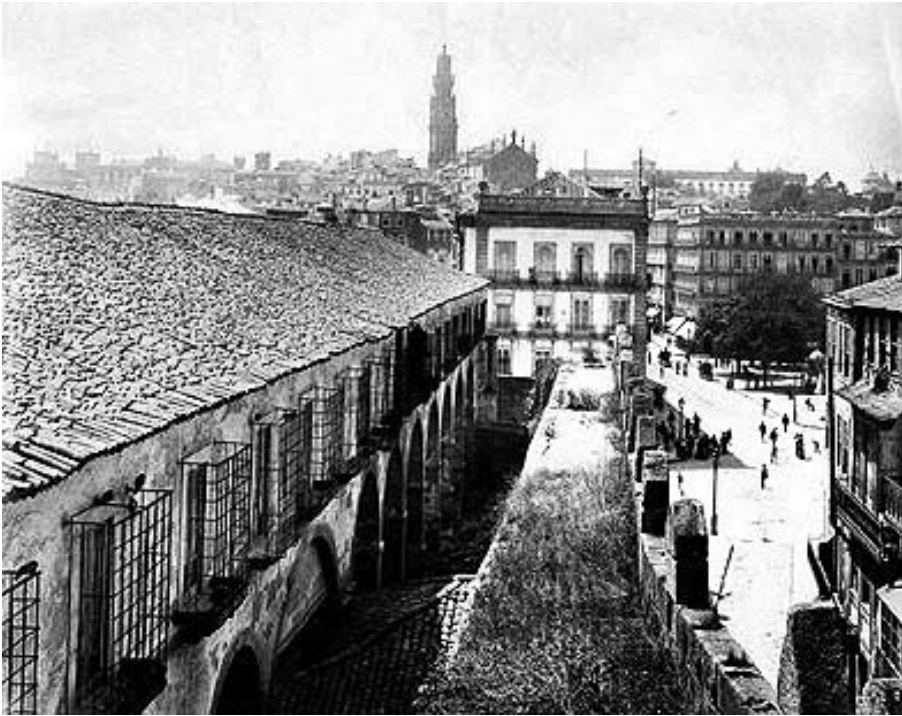
43. Lado norte do convento de São Bento de Ave Maria e troço da muralha correspondente.
