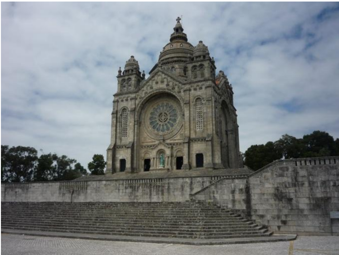
Figura 14 – Igreja de Santa Luzia, 1903-43, Viana do Castelo, de Ventura Terra
