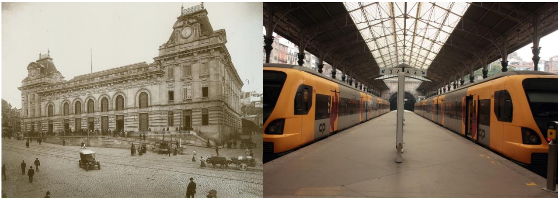
Figura 27 – Estação de São Bento, 1896-1916, Porto, de Marques da Silva
