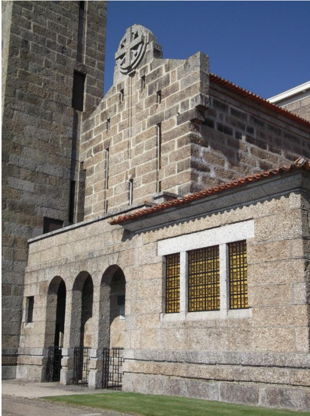
Figura 104 – Fachada principal da Igreja da Penha
