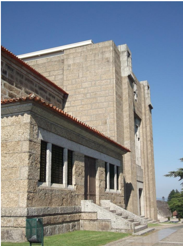
Figura 105 – Capelas posteriores com estereotomia diferente do volume da nave
