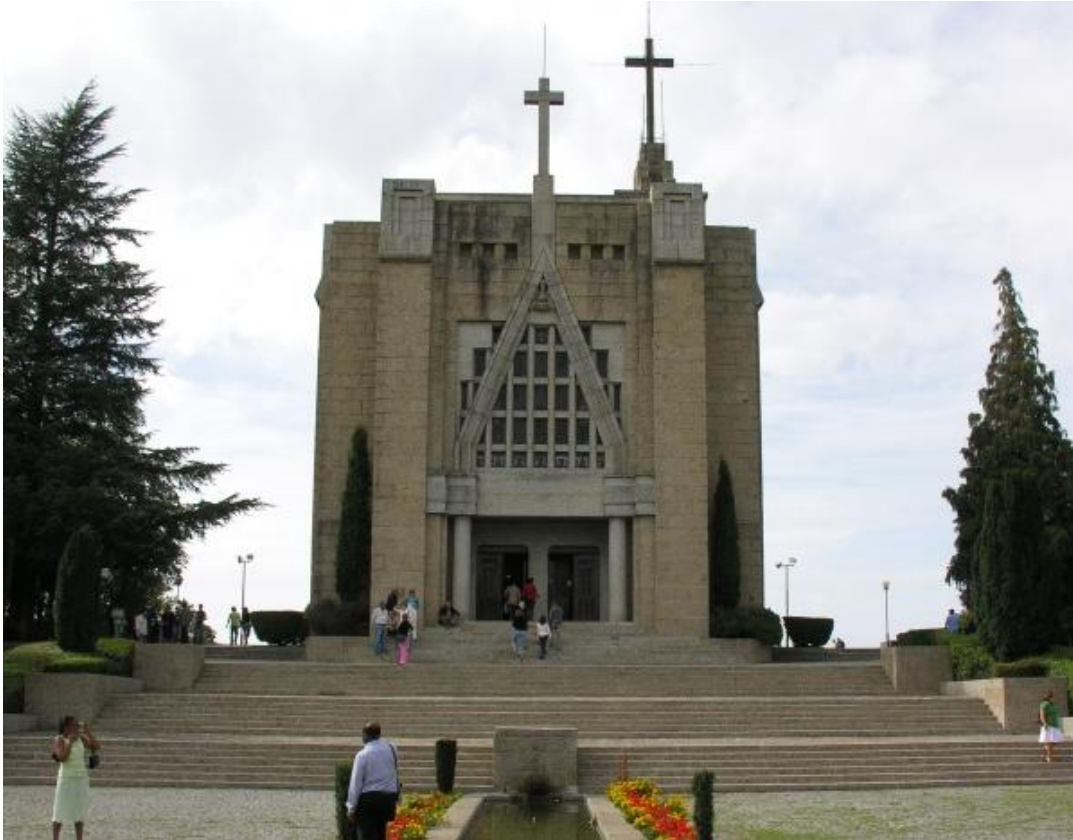
Figura 102 – Fachada principal da Igreja da Penha
