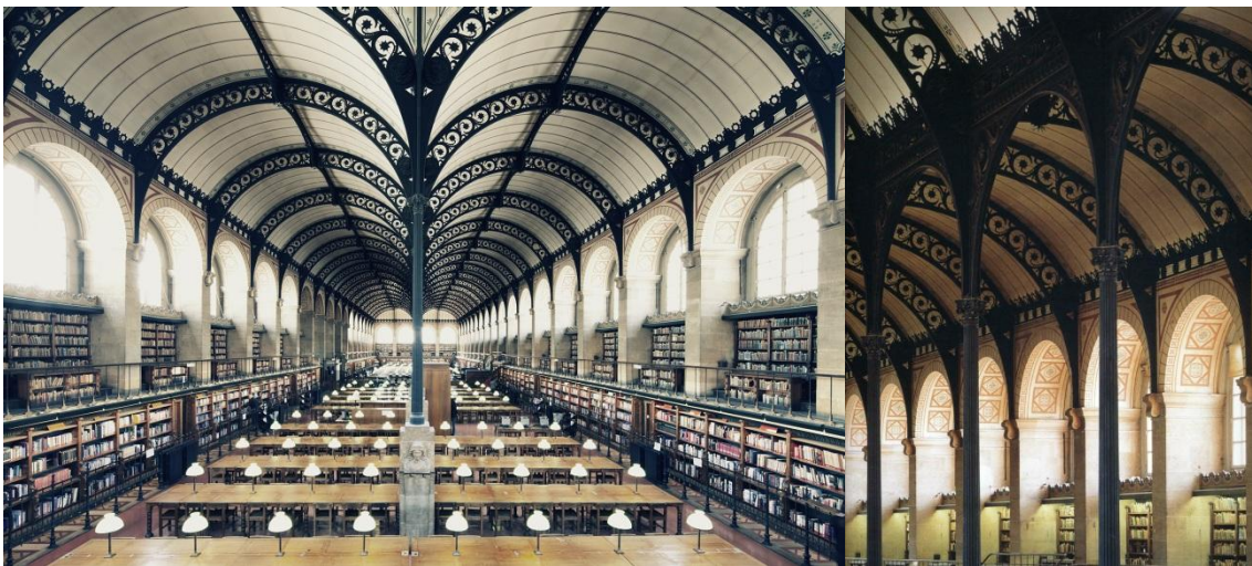
Figura 92 – Interior da Sala de leitura com a presença da estrutura de ferro e pormenor da estrutura de ferro, Biblioteca Ste. Geneviève
