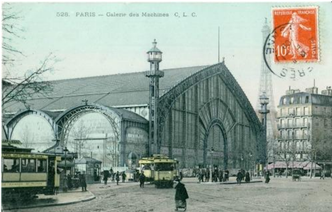
Figura 51 – Galeria das Máquinas, 1889, Paris, de Ferdinand Dutert
