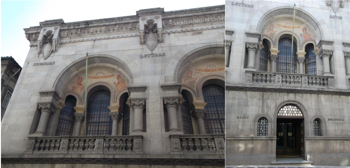
Figura 86 – Aberturas da fachada principal, Sociedade Martins Sarmento
