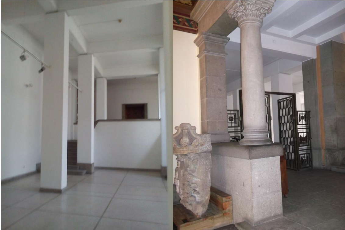
Figura 91 – Sala museu com a presença da estrutura de pilares e vigas de betão e pótico de entrada mostrando o confronto do granito com a estrutura de betão, Sociedade Martins Sarmiento
