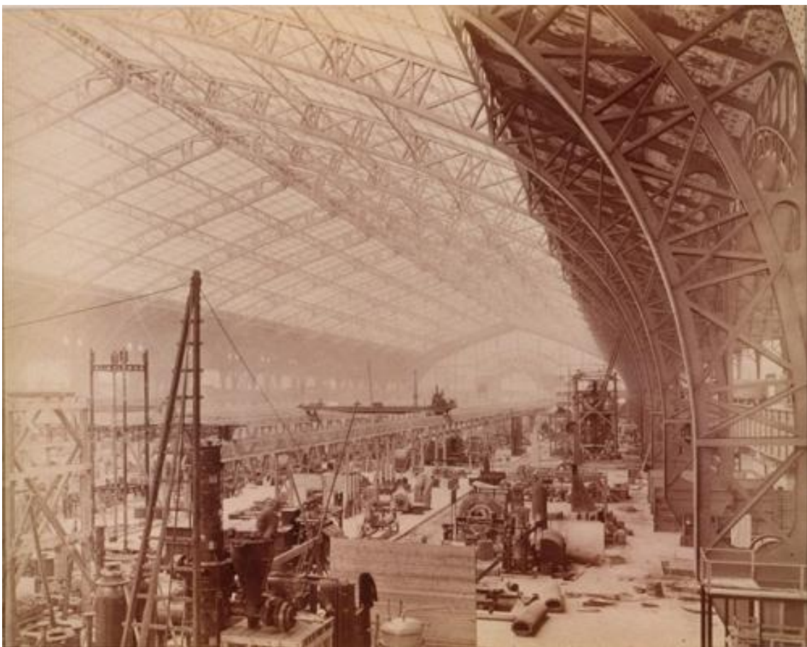
Figura 52 – Galeria das Máquinas, 1889, Paris, de Ferdinand Dutert
