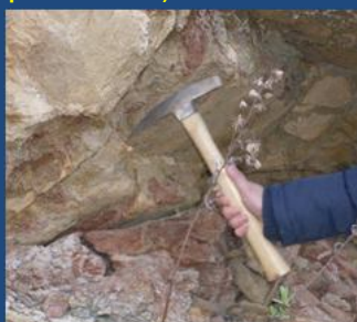
Talude na estrada Lamas - Condeixa
