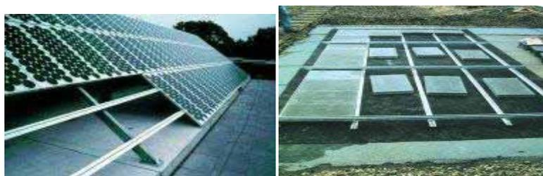
**Figura 3.18.** Esquerda: Montagem em lajes de fundação e direita: Lastragem com lajes de betão inseridas em secções metálicas [2]
