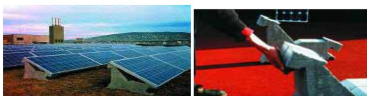
**Figura 3.19.** O sistema de base de cimento usa duas bases por painel: sendo a armação do módulo fixada com grampos de aço inoxidável [2]
