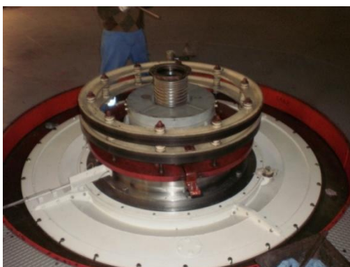
Figura 58. Montagem da cuba de óleo da chumaceira combinada. Montagem da excitatriz.
