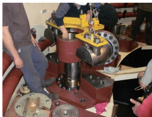
Figura 53. Montagem dos servomotes nas suas respectivas bases.
