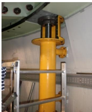
Figura 26. Montagem do macaco mecânico no respectivo local de funcionamento.
