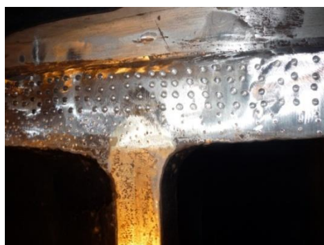
Figura 34. Preparação de uma das superfícies para reparação da vedação da tampa superior da turbina.
