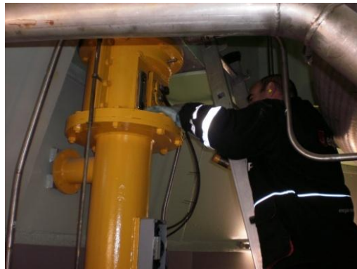
Figura 29. Ajustagem dos fins de curso de fecho.
