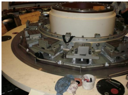
Figura 54. Montagem do anel suporte de patins da chumaceira combinada e tubagem da injeção preliminar.
