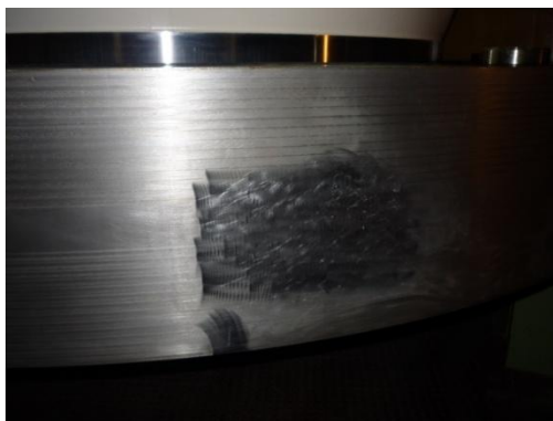
Figura 39. Antiga furação de passagem do óleo da chumaceira combinada na lentilha, devidamente tamponada.
