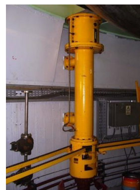
Figura 31. Montagem do macaco mecânico concluída.
