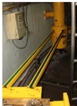
Figura 27. Montagem das calhas das correntes da cadeia de sincronização.
