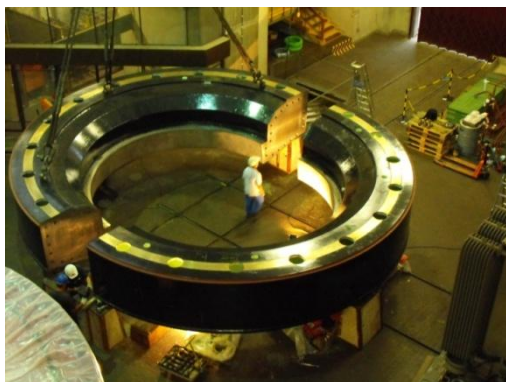
Figura 42. Preparação das superfícies de acoplamento das duas metades da tampa inferior da turbina.
