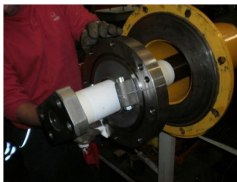
Figura 25. Montagem da tampa do bucim.
