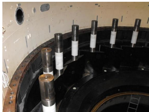
Figura 48. Montagem das primeiras pás directrizes. Figura 49. Montagem das pás directrizes completa.
