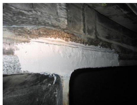
Figura 35. Superfície de vedação reparada.
