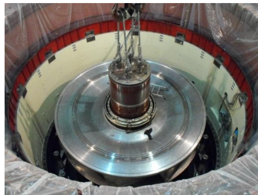
Figura 51. Montagem do conjunto veio da turbina/roda/cone no seu local de funcionamento.
