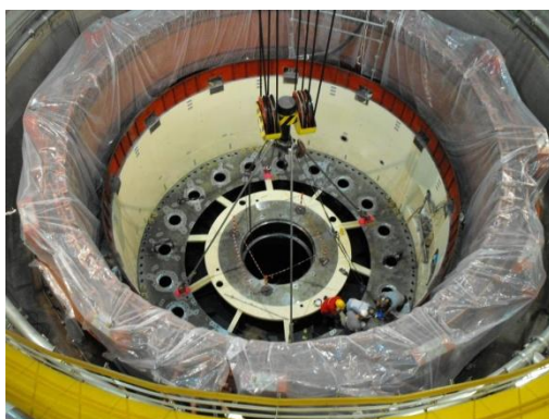
Figura 44. Descida da tampa superior da turbina para pré-montagem.
