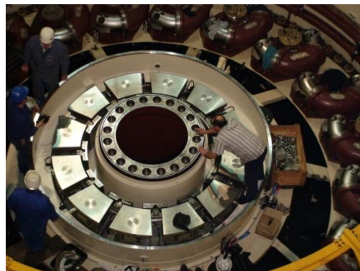
Figura 55. Montagem da meia cuba exterior da chumaceira combinada e patins radiais.
