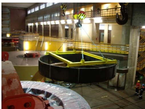
Figura 9. Manobra do obturador da válvula cilíndrica.
