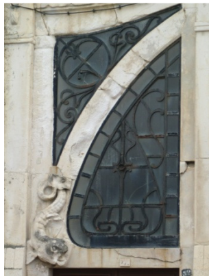
c) Cantaria de calcário, ferro forjado e vidro
