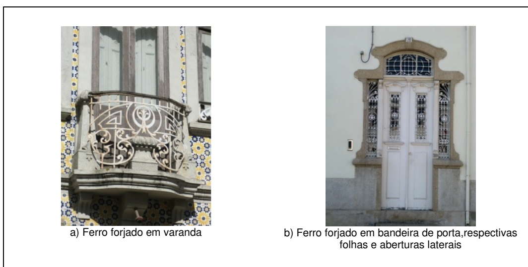
Fig. 10 - Características de aplicação de ferro forjado em porta e bandeiras e varanda
