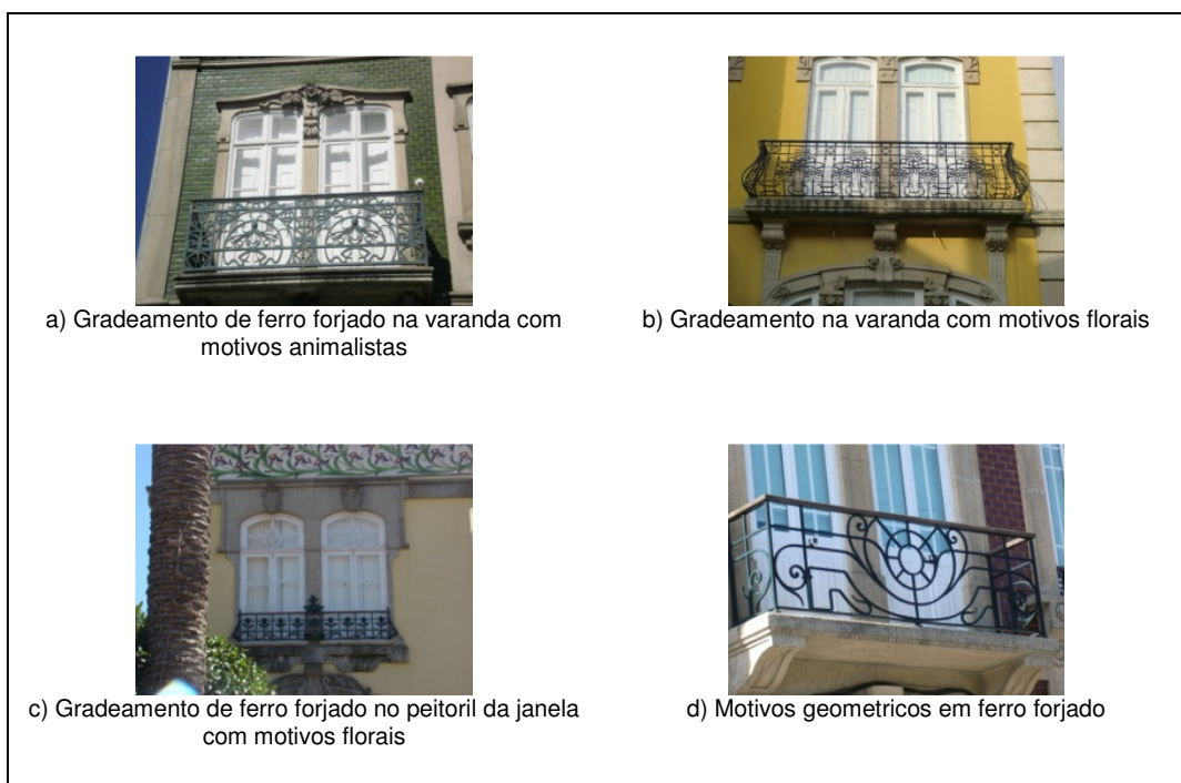
Fig. 9 - Características de aplicação de ferro forjado em varandas
