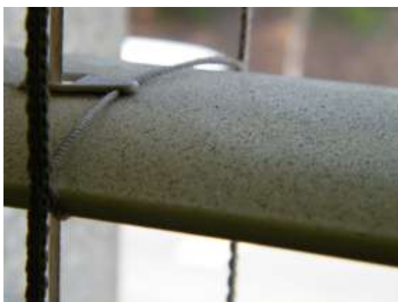
Figura C.5 – Partículas acumuladas nos estores.
