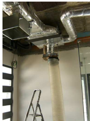
Figura 8. Aspiração da conduta a ser limpa.
