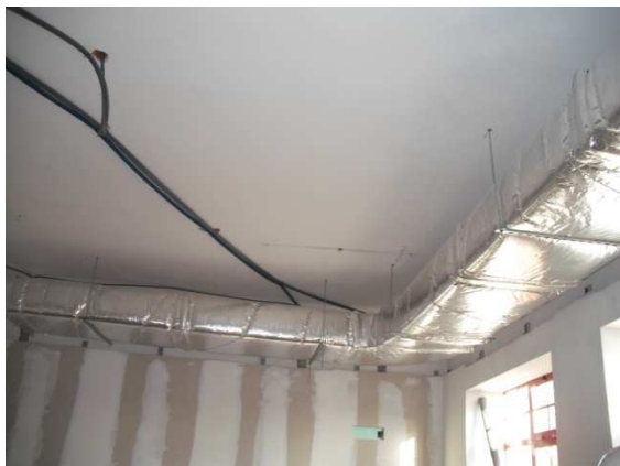
Figura 19. Isolamento exterior da conduta.
