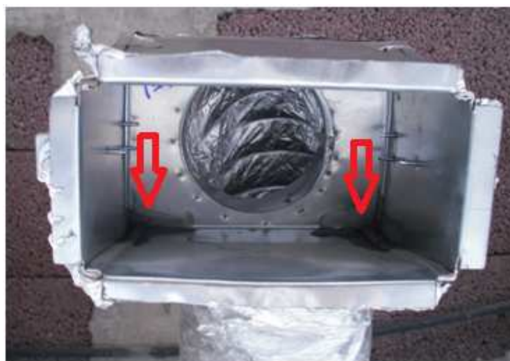
Figura 25. Pleno isolado com silicone.
