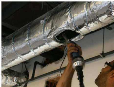
Figura 7. Inserção da escova rotativa na conduta a ser limpa.
