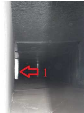
Figura 35. Interior da conduta.
