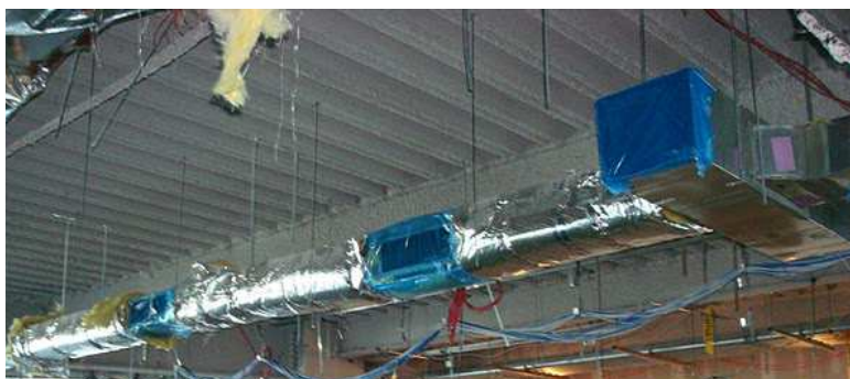
Figura 36. Exemplo de como selar as condutas corretamente ( U.S. Coast Guard ).
