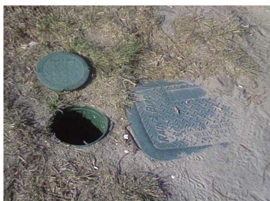
Figura 29 – Sifões do sistema de rega
