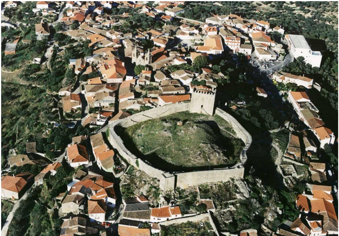
Foto 8 – Vista aérea sobre a implantação do Castelo e Vila de Celorico da Beira.
