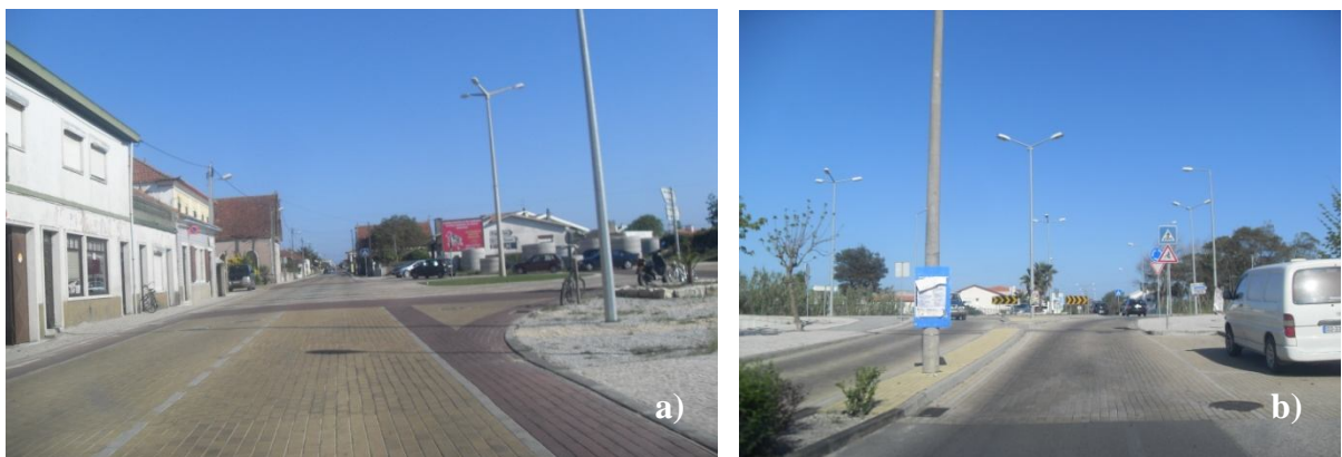
Figura 2.10 – Plataforma em intersecção, com alteração de material (Mira)
