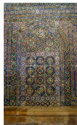
Fig. 40. Pormenor de colocação. Sé Velha de Coimbra.
