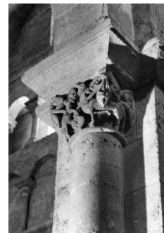
Fig. 9. Pormenor de um capitel da Sé Velha de Coimbra.
