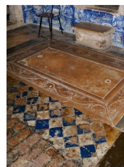
Fig. 99. Conjunto de azulejo de Xadrez aplicado como pavimento.
