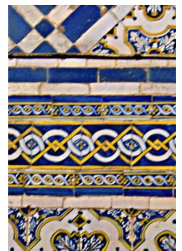
Fig. 102. Pormenor da cercadura divisória.
