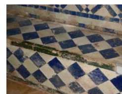
Fig. 96. Revestimento em Xadrez. Bancos do Refeitório do Mosteiro de Santa Cruz.
