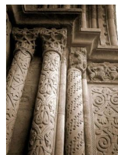
Fig. 10. Pormenor do pórtico da Sé Velha de Coimbra.
