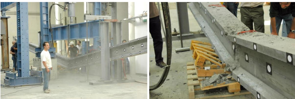
Figura 4.44: Aspecto após colapso da viga 2
