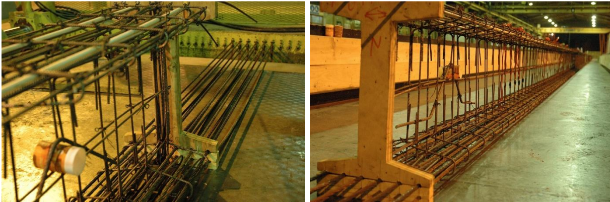
Figura 4.10: Pormenor da armadura e da secção após colocação dos cabos de pré-esforço
