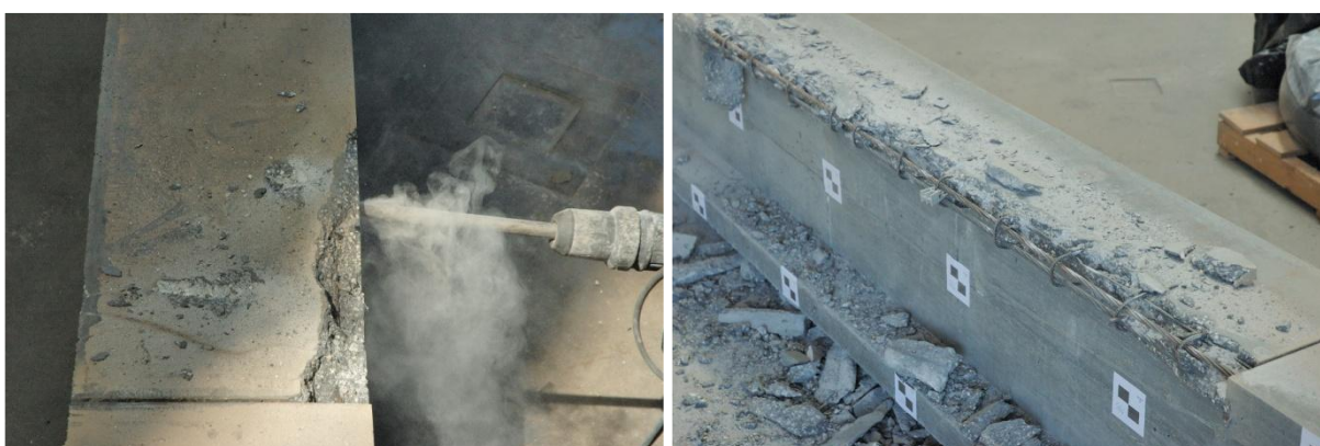
Figura 4.46: Decapagem dos cordões de pré-esforço
