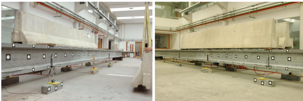
Figura 5.8: Colocação dos separadores de estrada
