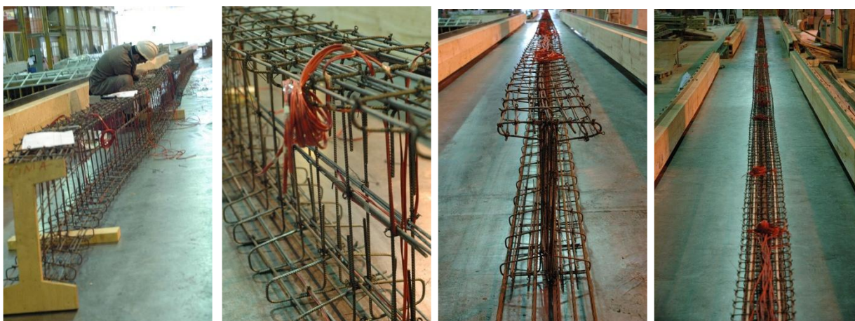
Figura 4.9: Colagem de extensómetros nas secções predefinidas, após montagem das armaduras
